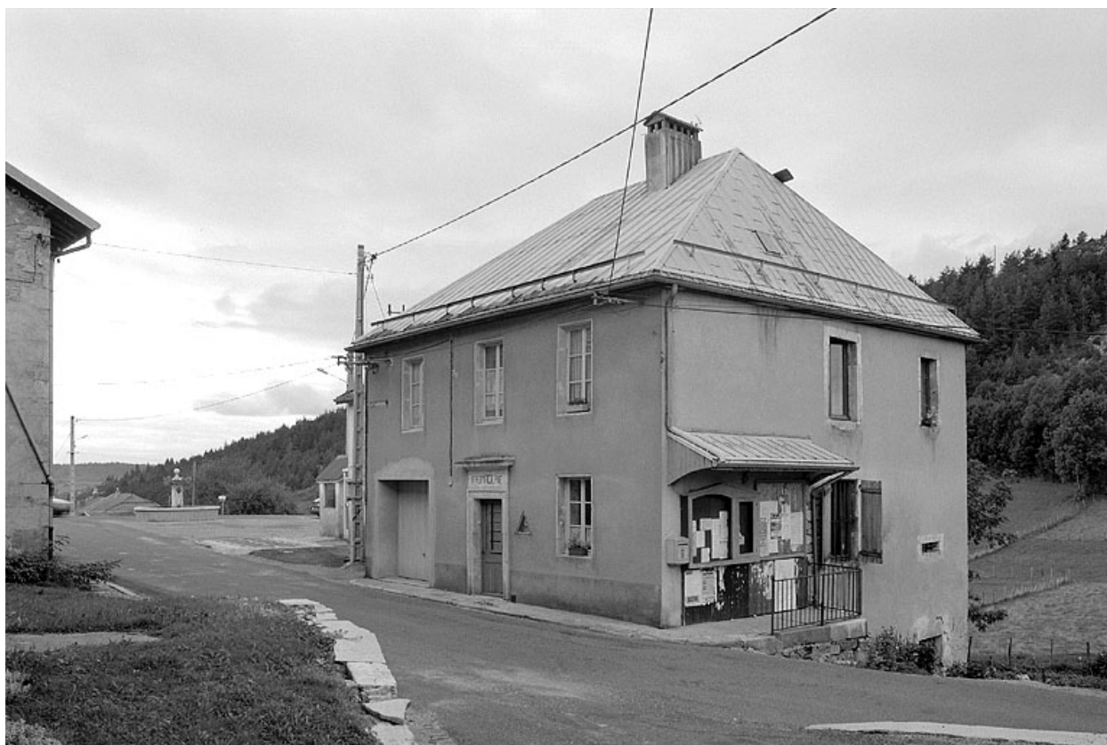
Façade antérieure et face latérale droite.
