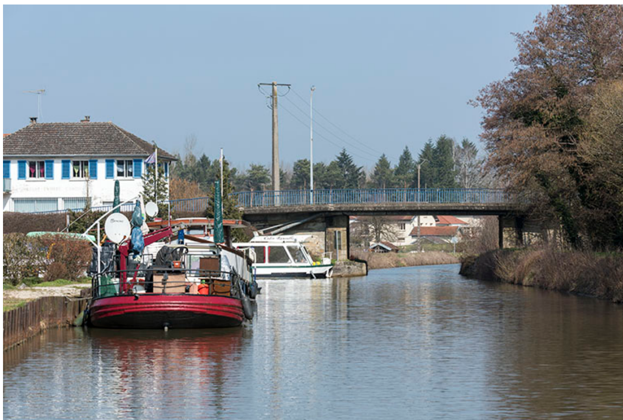
Pont sur le canal, vu de l'aval.
