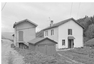
Face nord-est. Phot. Jérôme Mongreville IVR43_19963901626X
