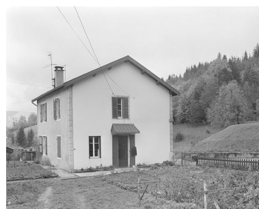
Façade postérieure et face nord-est. Phot. Jérôme Mongreville IVR43_19963901627X
