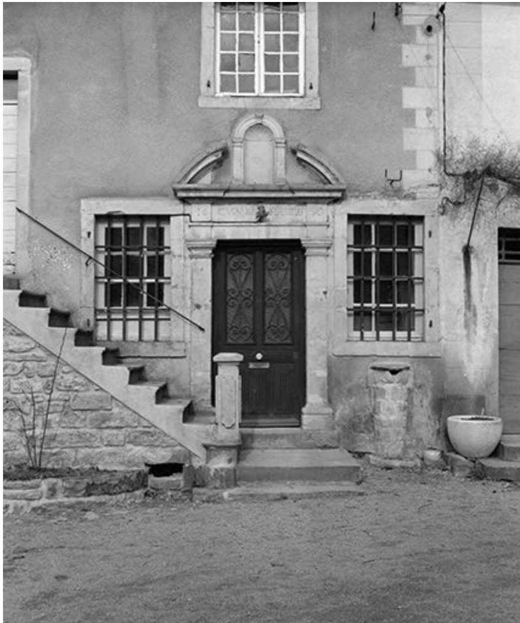
Façade antérieure, détail du rez-de-chaussée.
