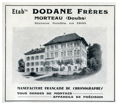
Etab[li]ssement Dodane Frères. Morteau (Doubs) [façade postérieure de la maison et de l'usine], 1943. IVR43_20172501408NUC2A
