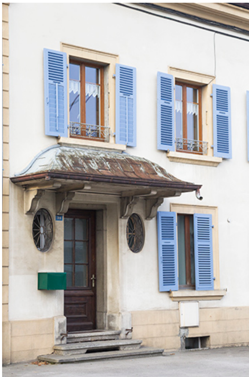
Façade antérieure : entrée du logement patronal.
