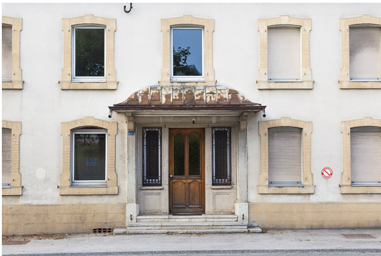
Façade antérieure : entrée de l'atelier de fabrication.
