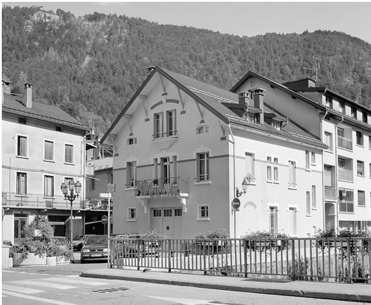
Façades antérieure et latérale droite.
