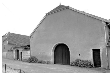
Vue d'ensemble depuis la rue. Phot. Dominique Dominguez IVR43_19807000451X
