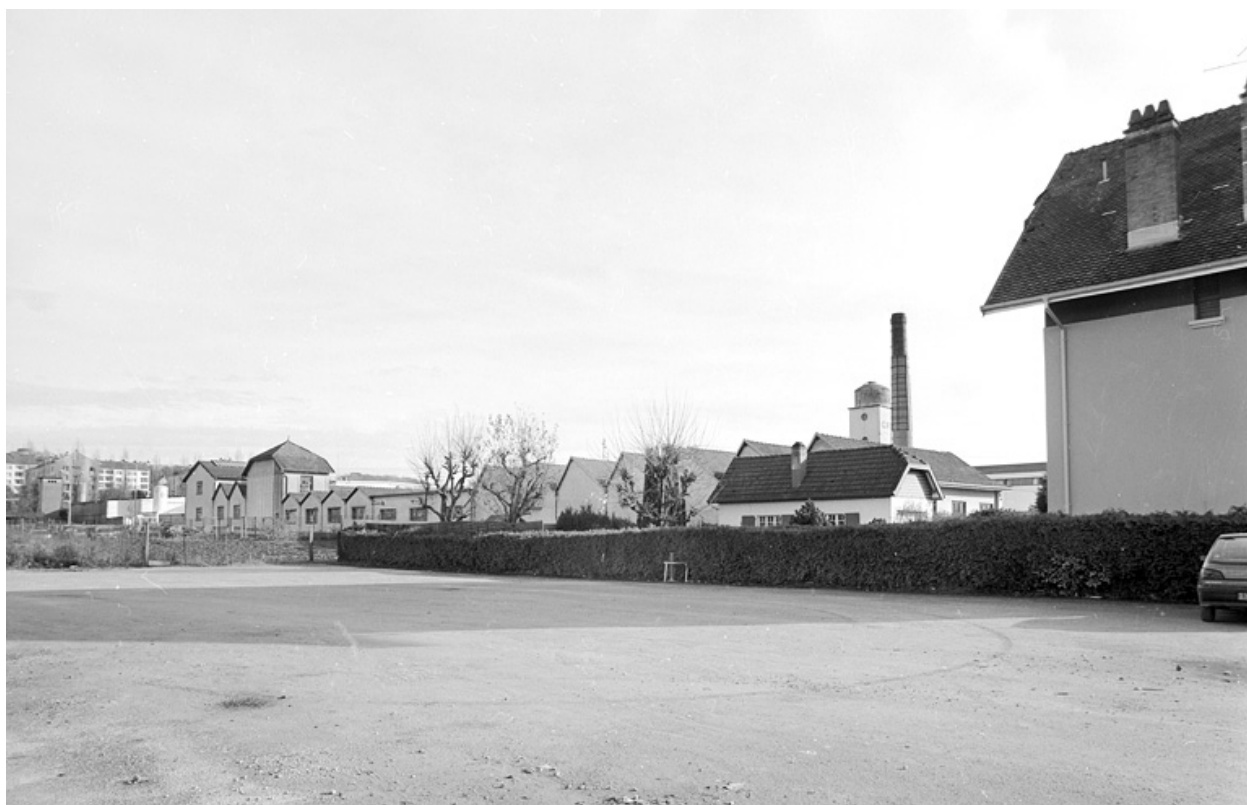
Murs-pignons nord de l'usine.
