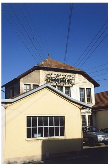
Transformateur. Phot. Yves Sancey IVR43_20009000953ZA
