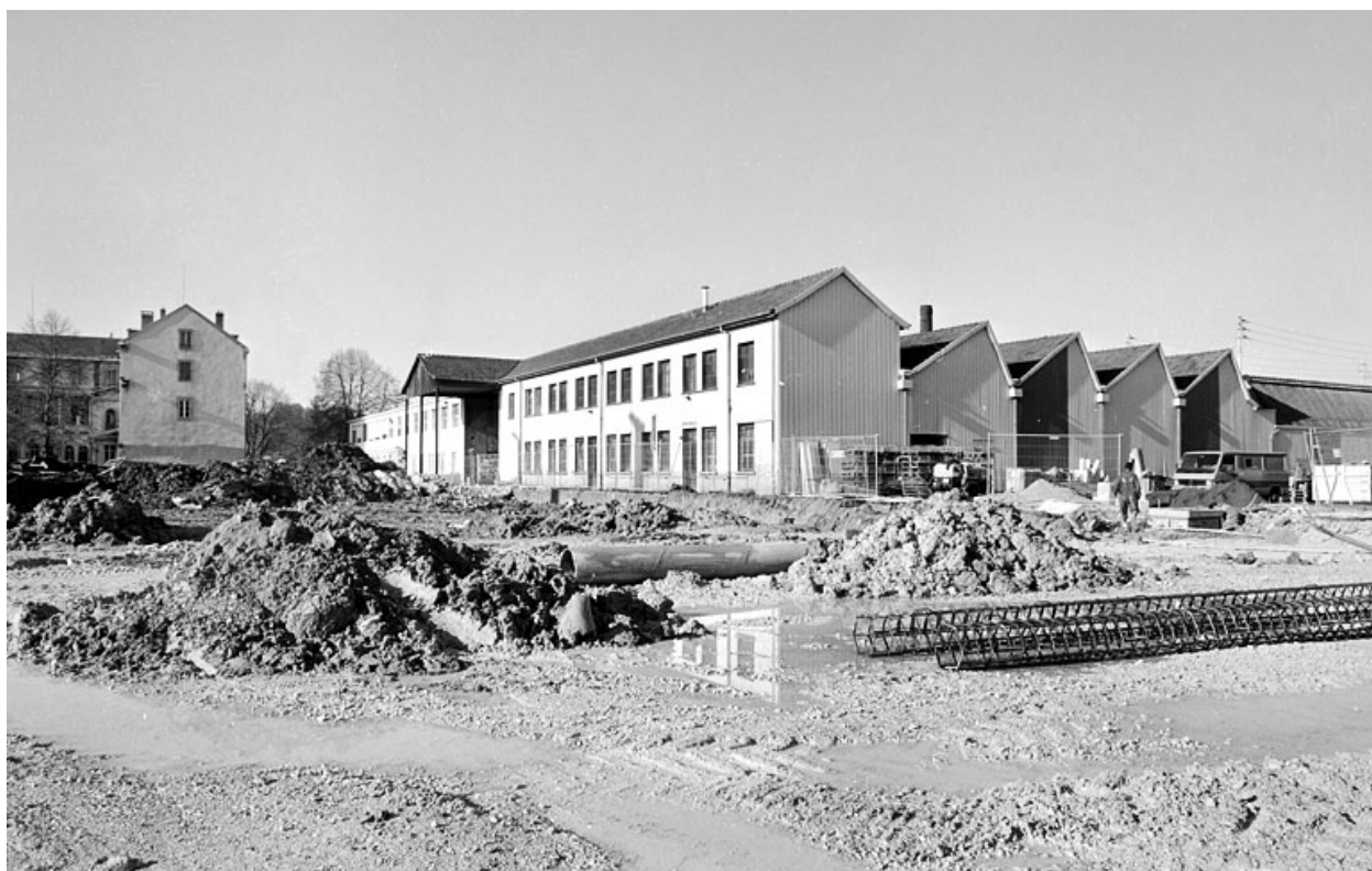
Façades postérieures des ateliers de fabrication.
