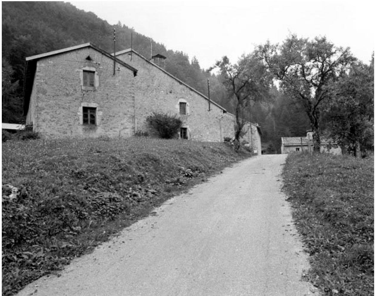
Ferme située au lieu-dit À la Boissière.
