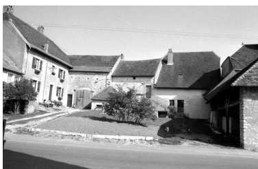
Vue d'ensemble. Phot. Bernard Lardière IVR43_19797000111Z
