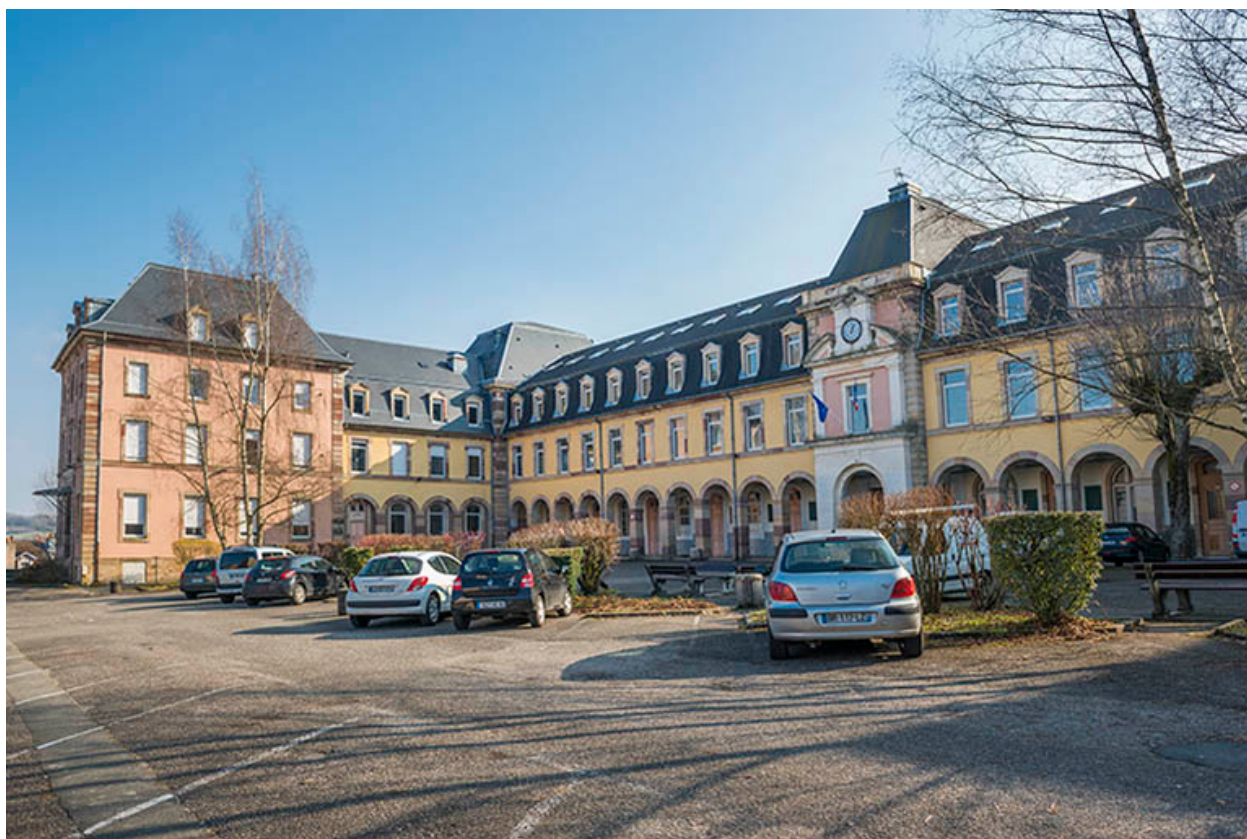
Cour d'honneur, façade antérieure (nord) du corps central et aile est du grand lycée.
