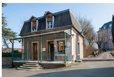
Façade antérieure (nord) de la conciergerie.
