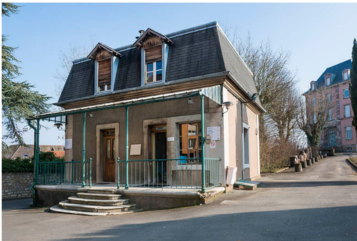
Façade antérieure (nord) de la conciergerie.
