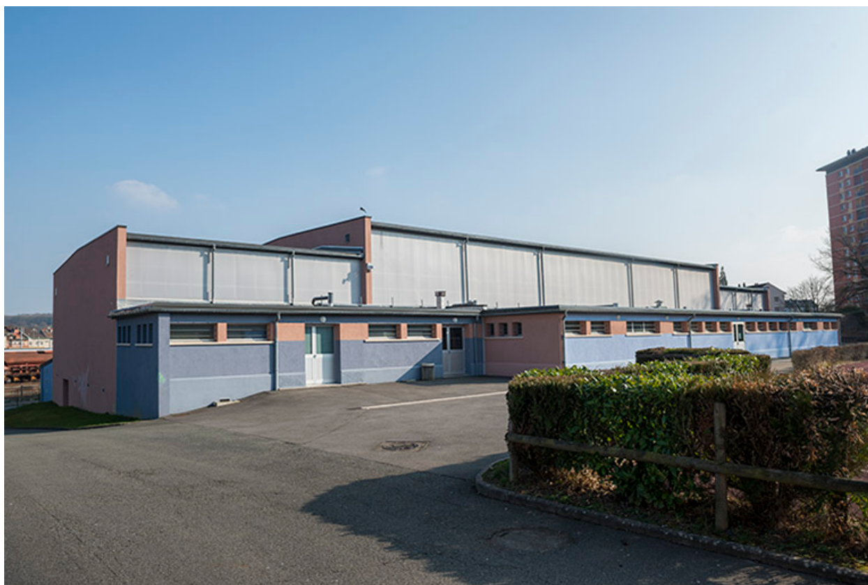
Angle nord-ouest du gymnase, façade antérieure.
