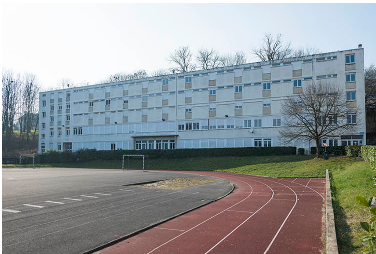
Stade, façade antérieure (est) de l'internat.
