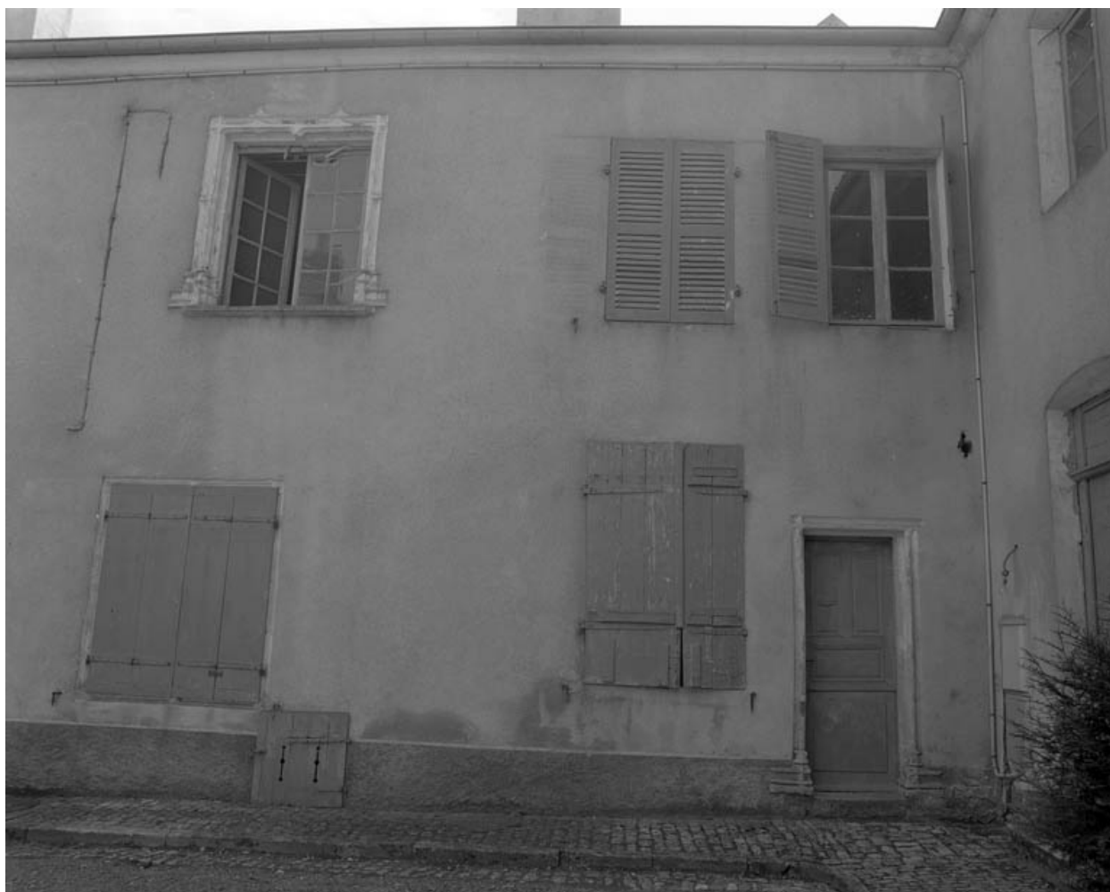
Façade antérieure du logement gauche sur cour.
