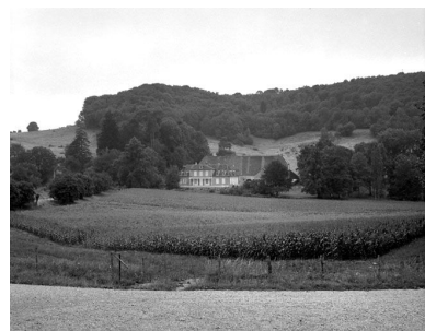
Demeure située route de Villeneuve au lieudit Pré de la Canne.
