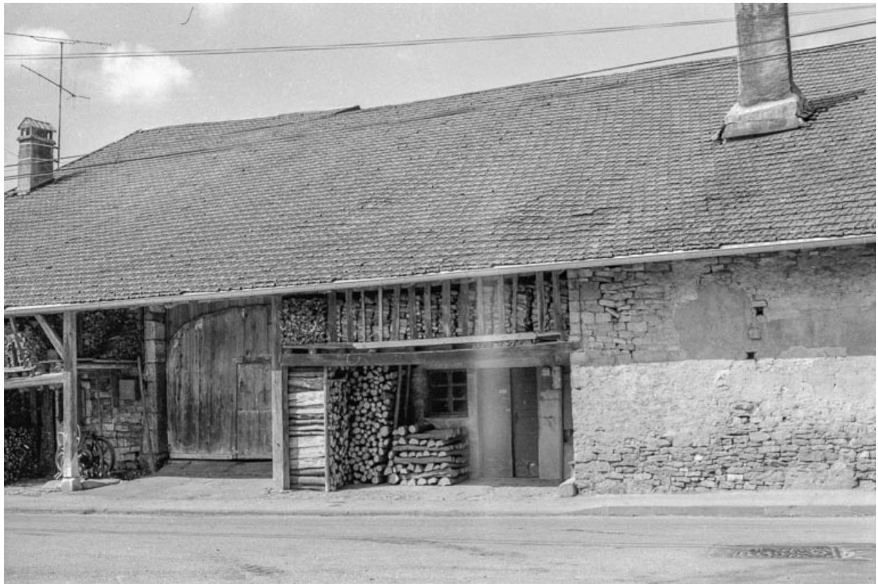
Détail de la façade sur rue.
