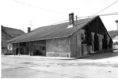
Vue de trois quarts gauche. Phot. Bernard Lardière IVR43_19782500327X
