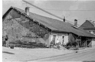
Façade sur rue et façade postérieure. Phot. Gilbert Poinot IVR43_19752501244Z
