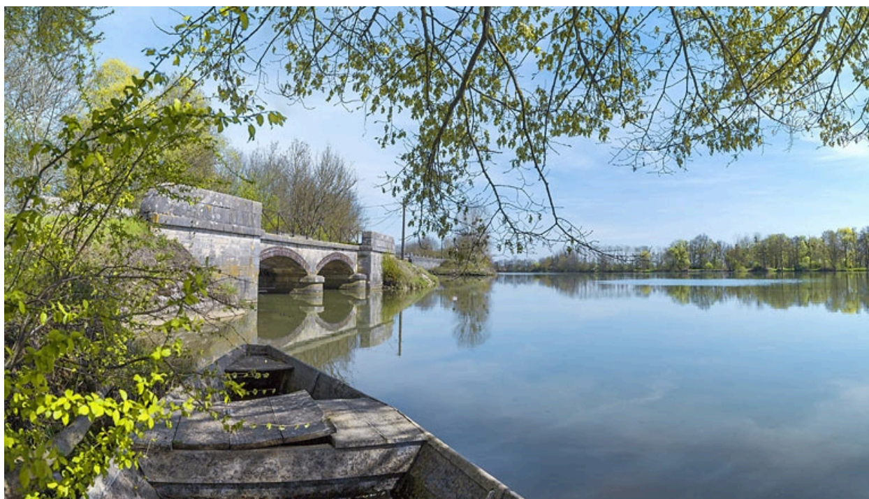
Vue d'ensemble, rive droite de la Saône.
