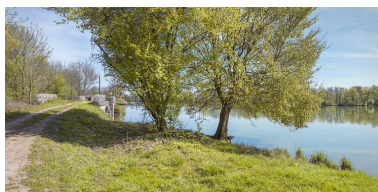
Vue d'ensemble, d'aval. Phot. Thierry Kuntz IVR26_20162101430NUC4A
