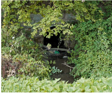
Vue de l'aqueduc. Phot. Pierre-Marie Barbe-Richaud IVR26_20112103697NUC2AQ
