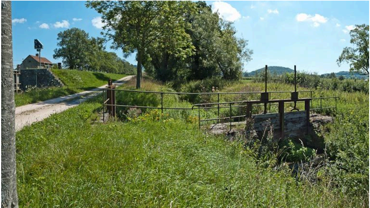
Vue des vannes de prise d'eau.
