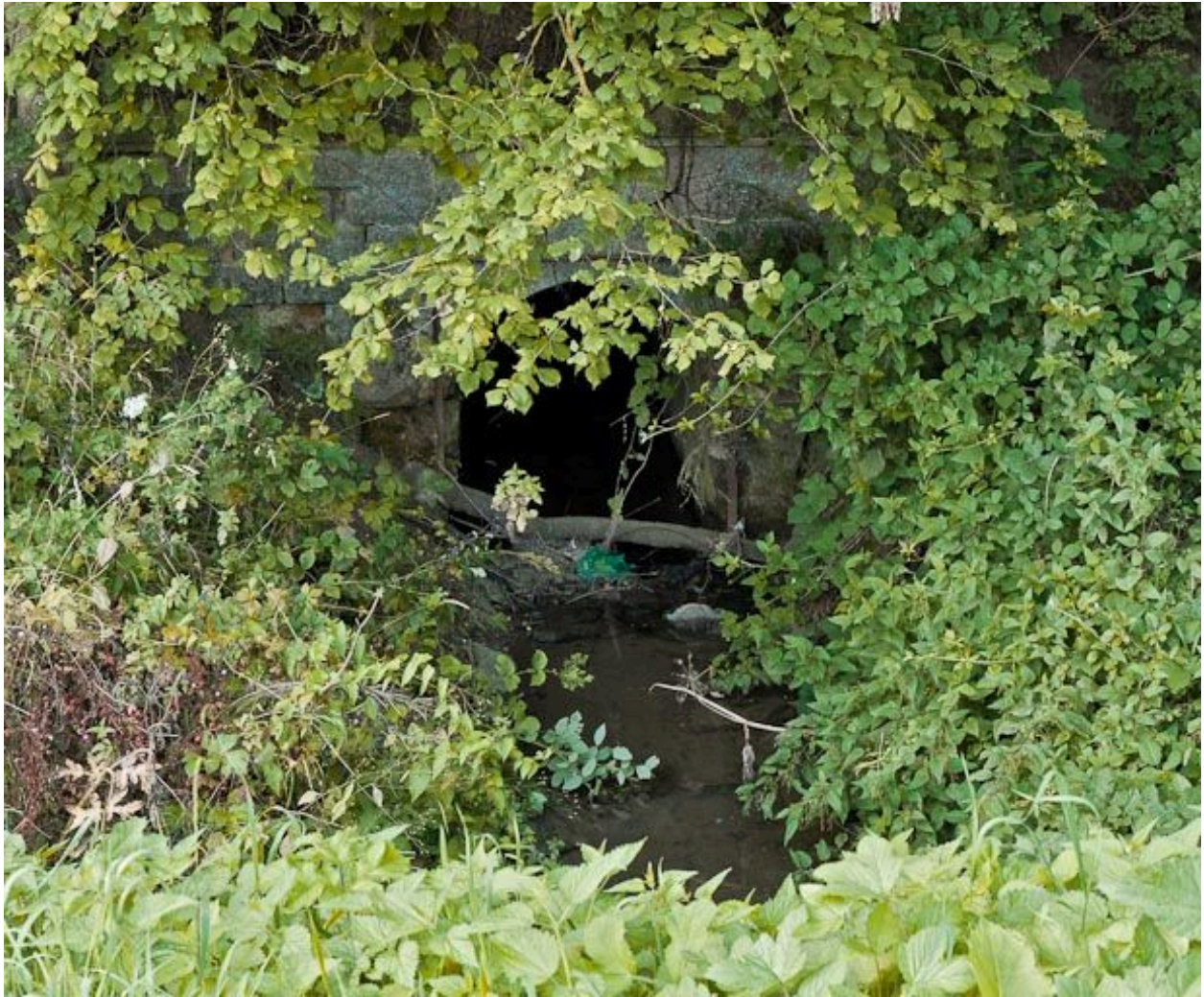
Vue de l'aqueduc.
