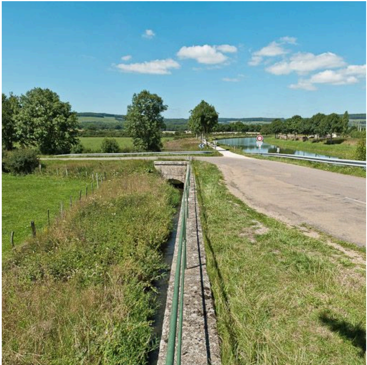
Vue du pont sur rigole.
