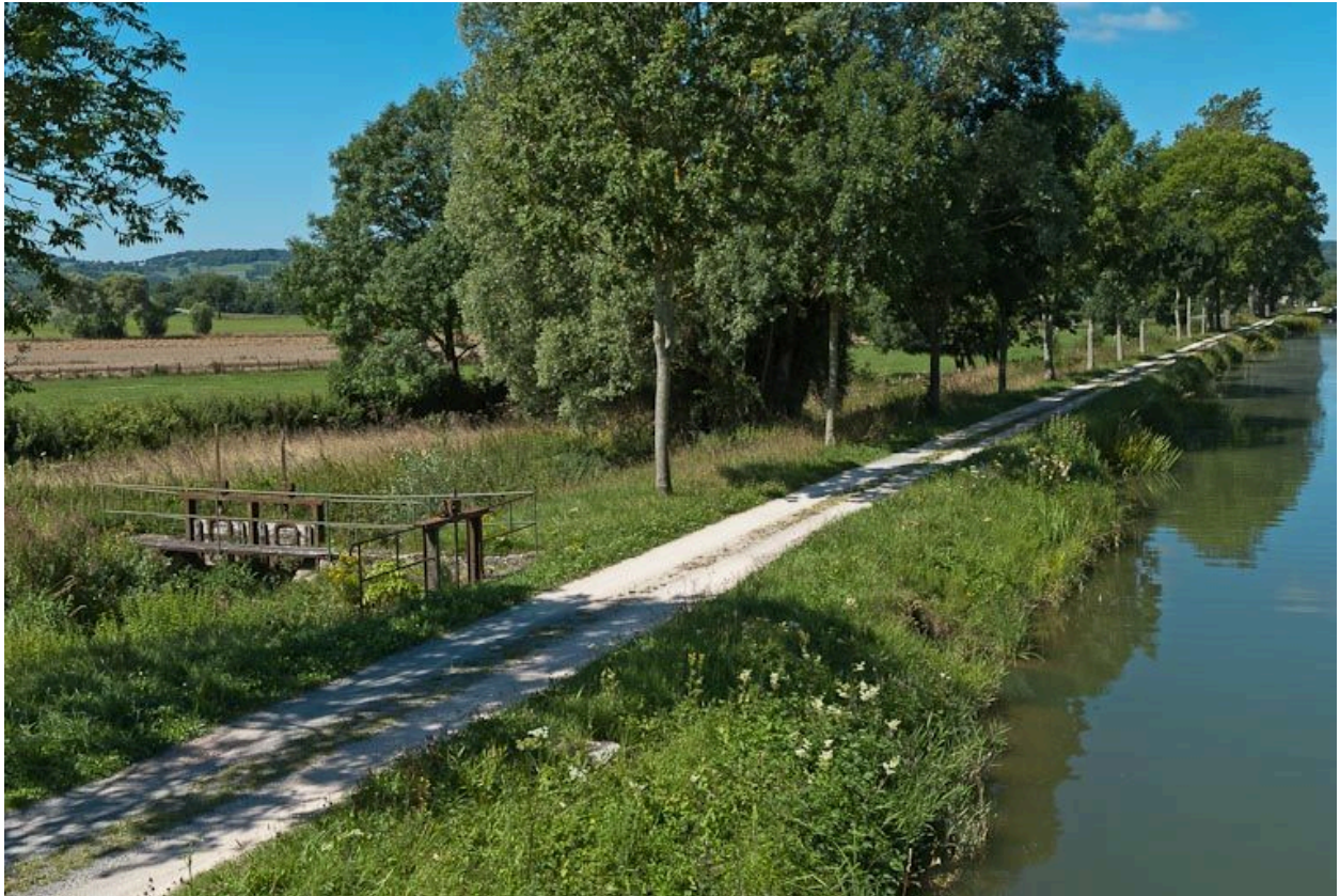
Vue des vannes de prise d'eau.
