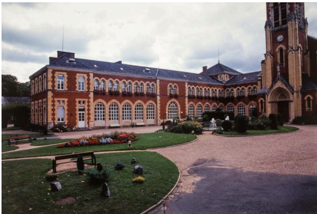
Aile gauche, façade antérieure.
