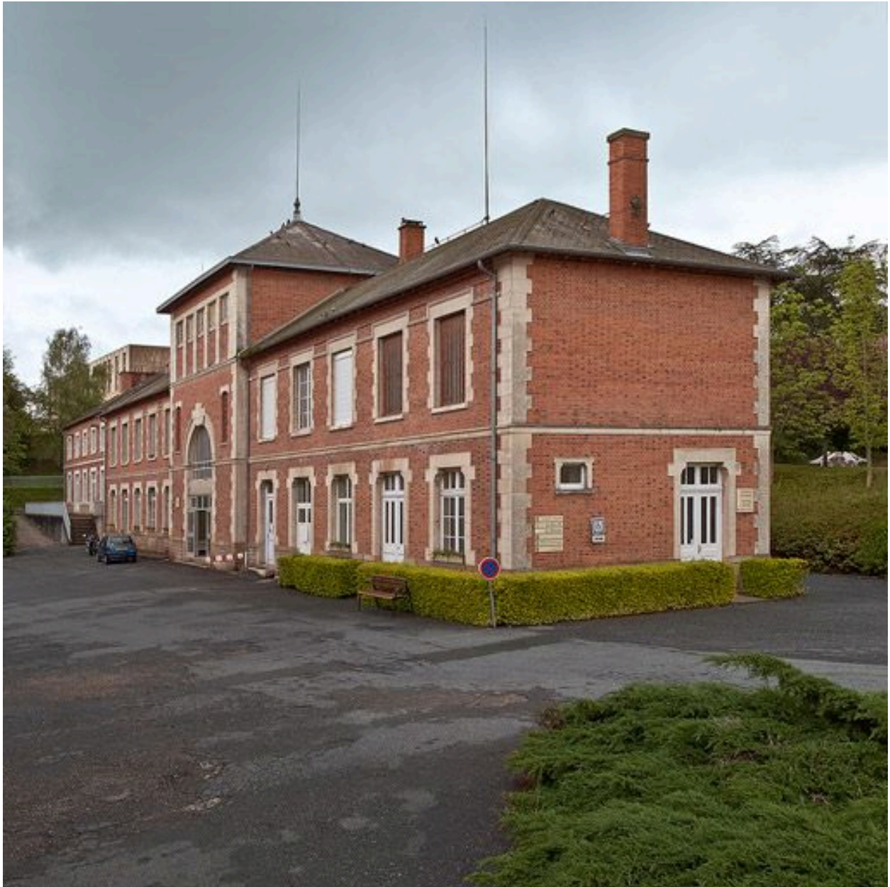
Bâtiment de services.
