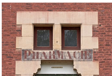
Pavillon de l'aile gauche : porte de l'ancienne pharmacie. Phot. Pierre-Marie Barbe-Richaud IVR26_20107100787NUC2A
