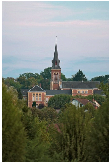
Elévations nord-ouest. Phot. Pierre-Marie Barbe-Richaud IVR26_20107100773NUC2A
