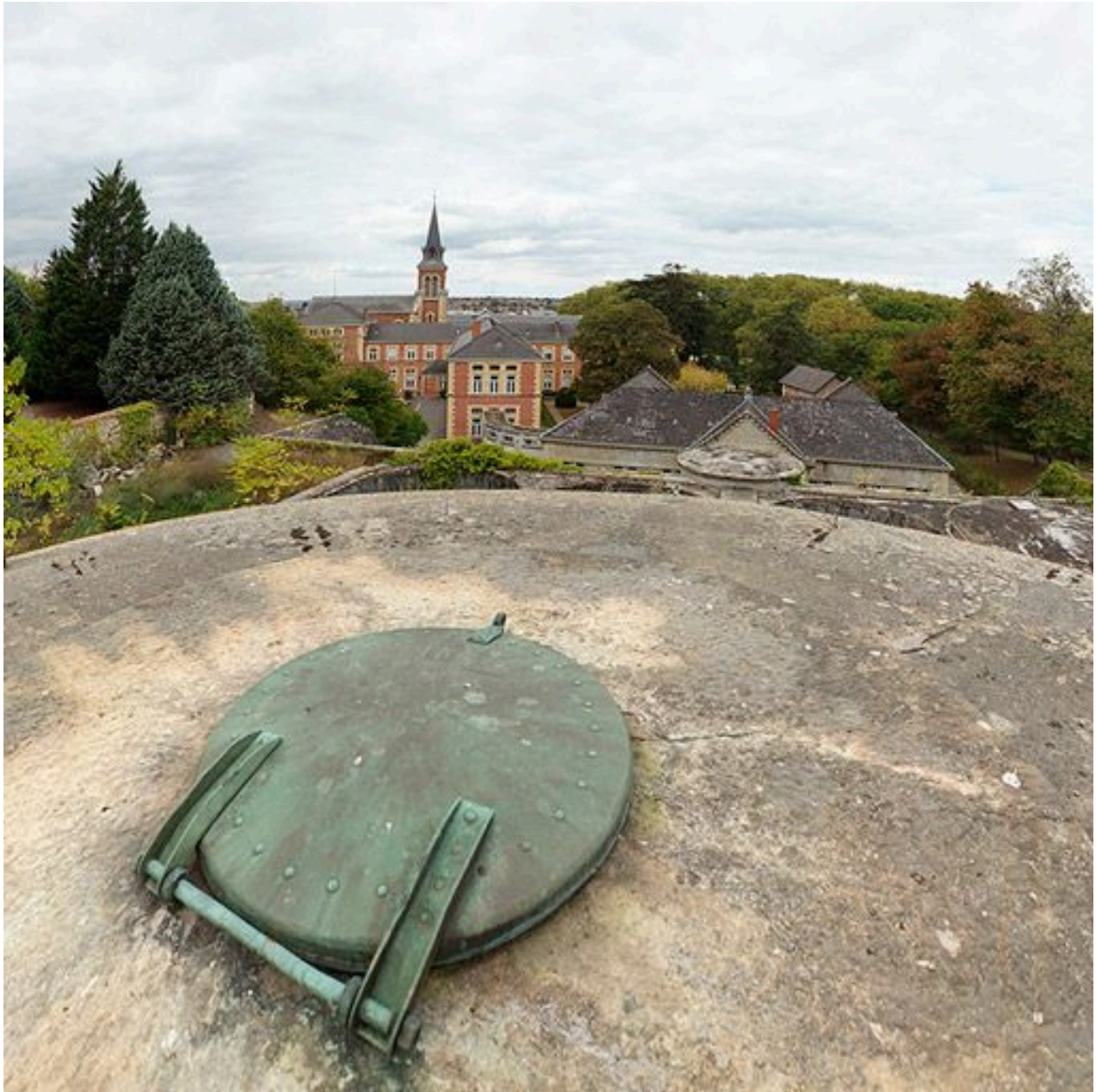
Vue d'ensemble de l'hôpital avec le trou d'homme du château d'eau au premier plan.
