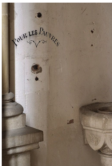
Porche : bénitier et tronc des pauvres. Phot. Pierre-Marie Barbe-Richaud IVR26_20107100813NUC2A
