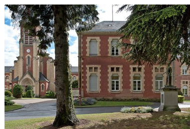
Chapelle et pavillon de l'aile droite. Phot. Pierre-Marie Barbe-Richaud IVR26_20107100776NUC2A
