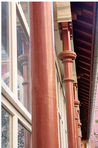
Colonnettes en fonte de la galerie derrière l'église. Phot. Pierre-Marie Barbe-Richaud IVR26_20107100791NUC2A
