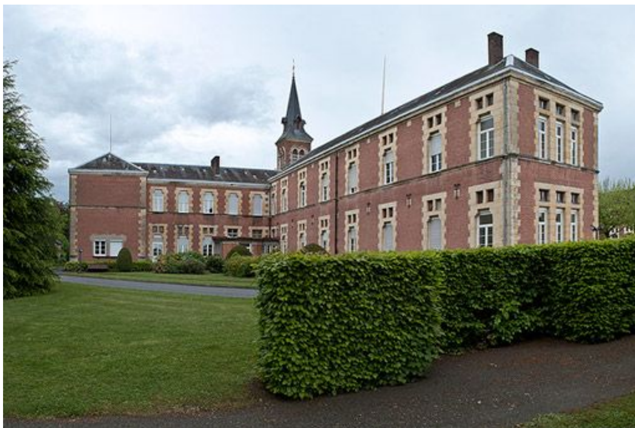
Aile droite et bâtiment en retour d'équerre.
