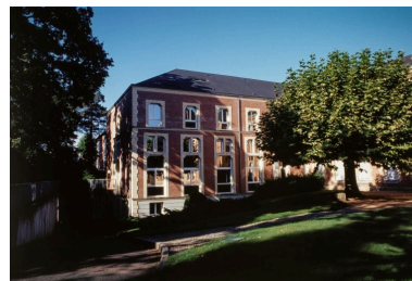
Façade postérieure, partie gauche. Phot. Jean-Luc Duthu IVR26_20017100719ZA
