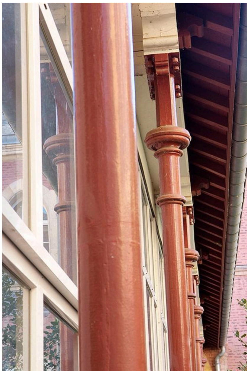
Colonnets en fonte de la galerie derrière l'église.
