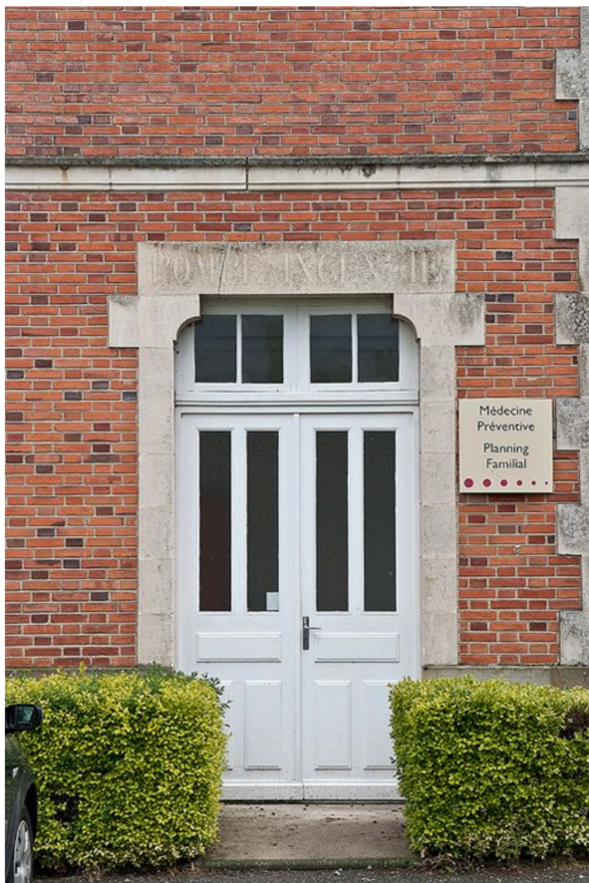
Bâtiment de services : porte latérale.
