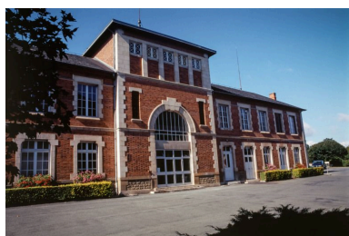
Bâtiment de service, façade antérieure. Phot. Jean-Luc Duthu IVR26_20017100721ZA
