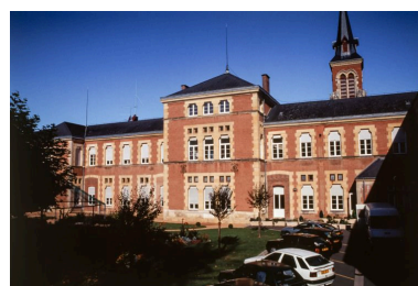
Façade postérieure de l'aile droite. Phot. Jean-Luc Duthu IVR26_20017100718ZA
