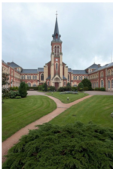
Façade de la chapelle.
