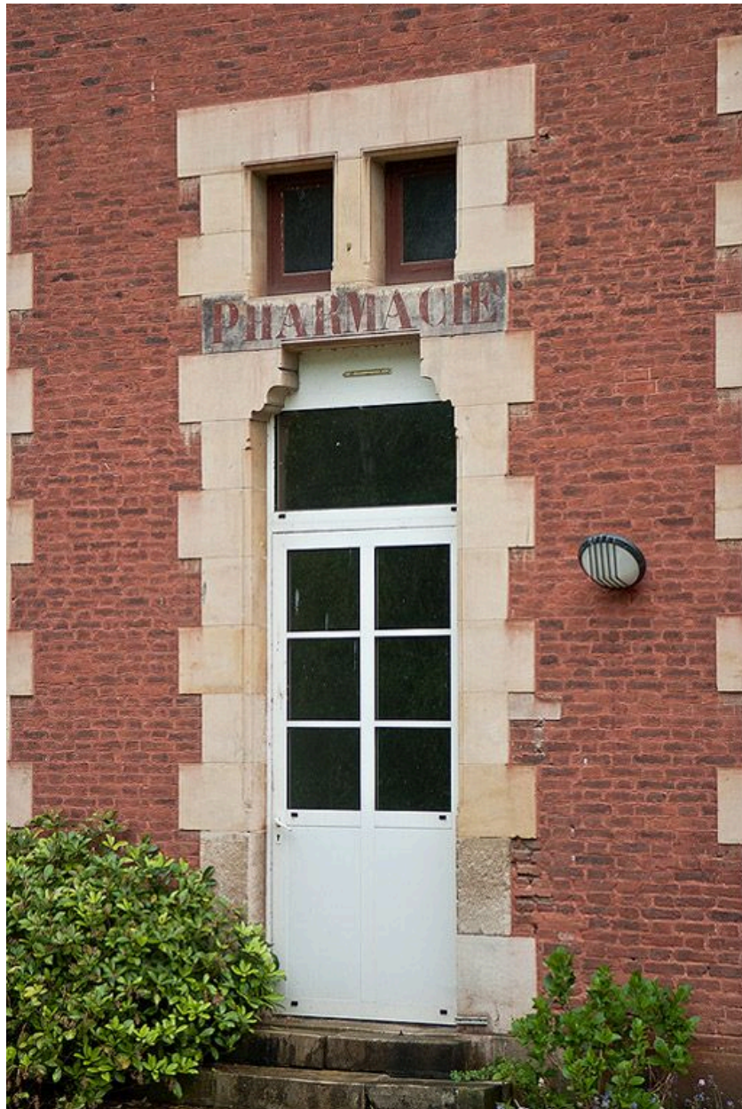
Pavillon de l'aile gauche : porte de l'ancienne pharmacie.
