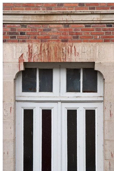
Bâtiment de services : détail. Phot. Pierre-Marie Barbe-Richaud IVR26_20107100794NUC2A
