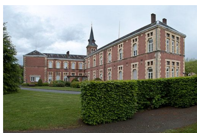
Aile droite et bâtiment en retour d'équerre. Phot. Pierre-Marie Barbe-Richaud IVR26_20107100777NUC2AQ
