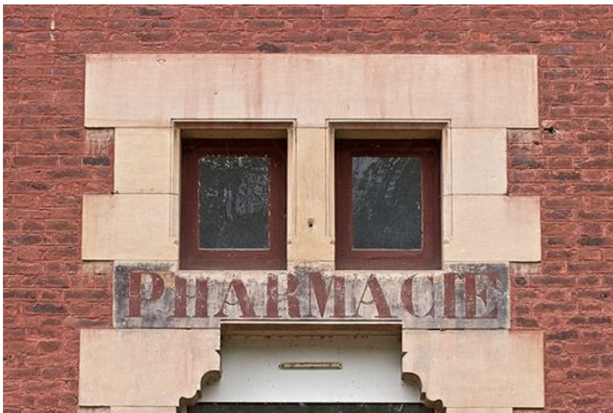
Pavillon de l'aile gauche : porte de l'ancienne pharmacie.
