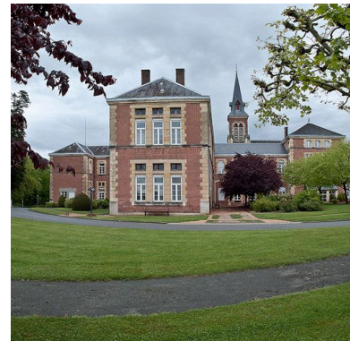
Elévation nord-ouest. Phot. Pierre-Marie Barbe-Richaud IVR26_20107100778NUC2AQ
