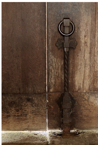
Chapelle : détail de la porte. Phot. Pierre-Marie Barbe-Richaud IVR26_20107100815NUC2A
