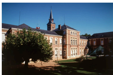
Façade postérieure de l'aile droite. Phot. Jean-Luc Duthu IVR26_20017100717ZA
