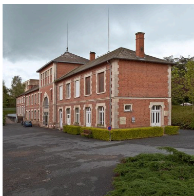
Bâtiment de services. Phot. Pierre-Marie Barbe-Richaud IVR26_20107100792NUC2AQ
