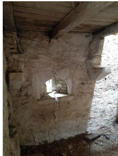
Détail de la gueule du four à pain.
