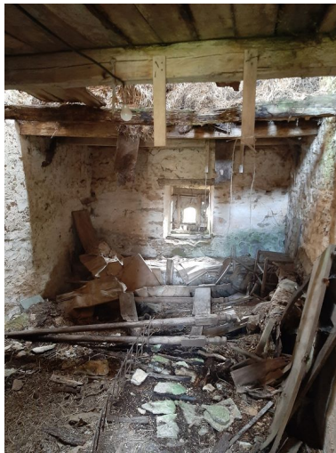
Vue de l'intérieur du fournil.
