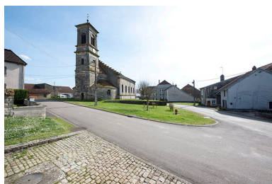
La place et le clocher de l'église saint-Brice, vus du nord. Phot. Sonia Dourlot IVR43_20177000283NUC4A
