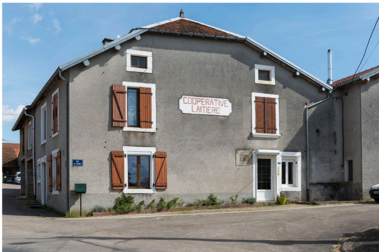
Ancienne coopérative laitière 6 rue du Cornot.
