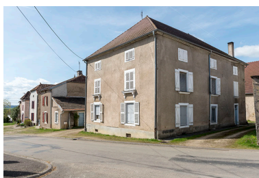
Alignement de façades Grande rue. Phot. Sonia Dourlot IVR43_20177000323NUC4A
