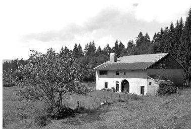
Façade sud-est, vue éloignée. Phot. Jérôme Mongreville IVR43_20003900453X
