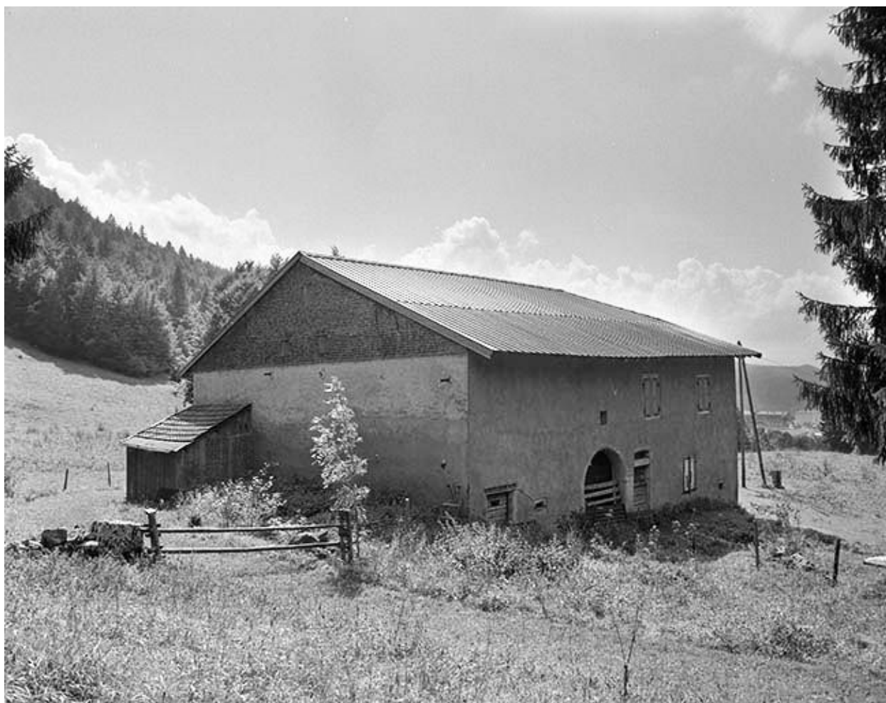
Façades nord-est et nord-ouest.
