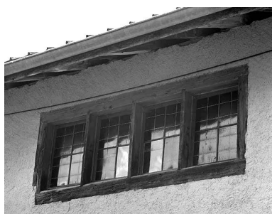
Fenêtres éclairant l'atelier ou "fenêtres de forge". Phot. Jérôme Mongreville IVR43_20003900456X
