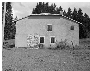
Façade sud-ouest. Phot. Jérôme Mongreville IVR43_20003900450X
