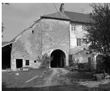
Le passage voûté. Phot. Yves Sancey IVR43_19802501463X
