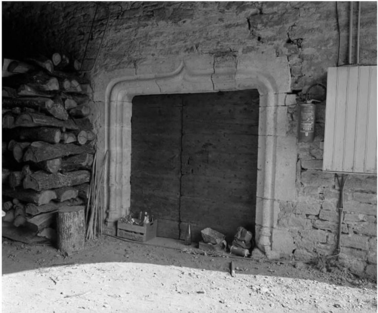
L'entrée du sous-sol sous le passage voûté.
