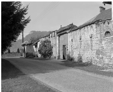
Le mur d'enclos. Phot. Yves Sancey IVR43_19802501152X
