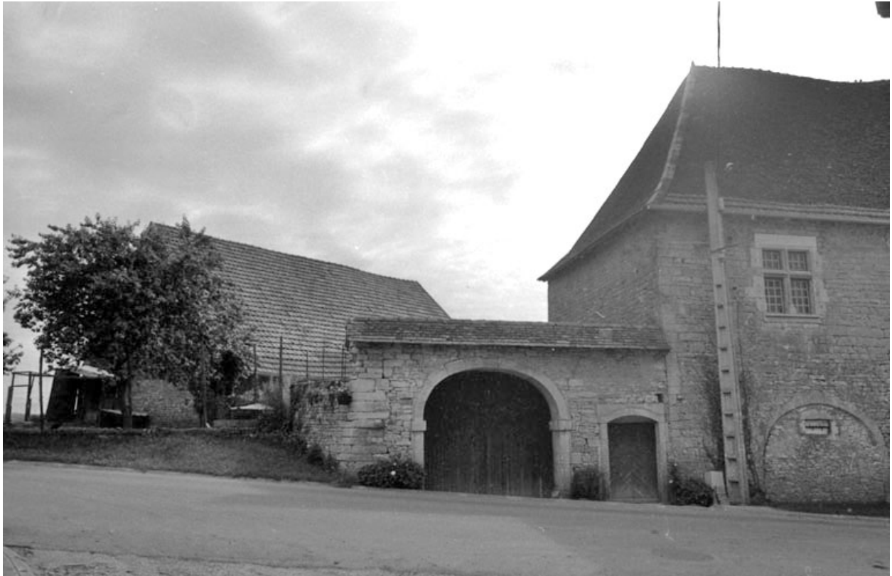
Portail d'entrée et bâtiment agricole.
