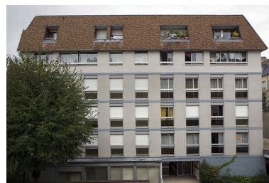
Vue d'ensemble de l'immeuble situé dans la cour. Phot. Yves Sancey IVR43_20082500420NUC2A
