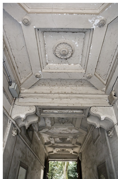
Détail du plafond du passage cocher : vue rapprochée. Phot. Yves Sancey IVR43_20082500417NUC2A
