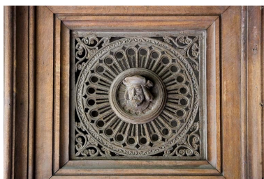
Détail du décor en fonte d'un des vantaux du portail d'entrée : tête d'homme. Phot. Yves Sancey IVR43_20082500410NUC2A
