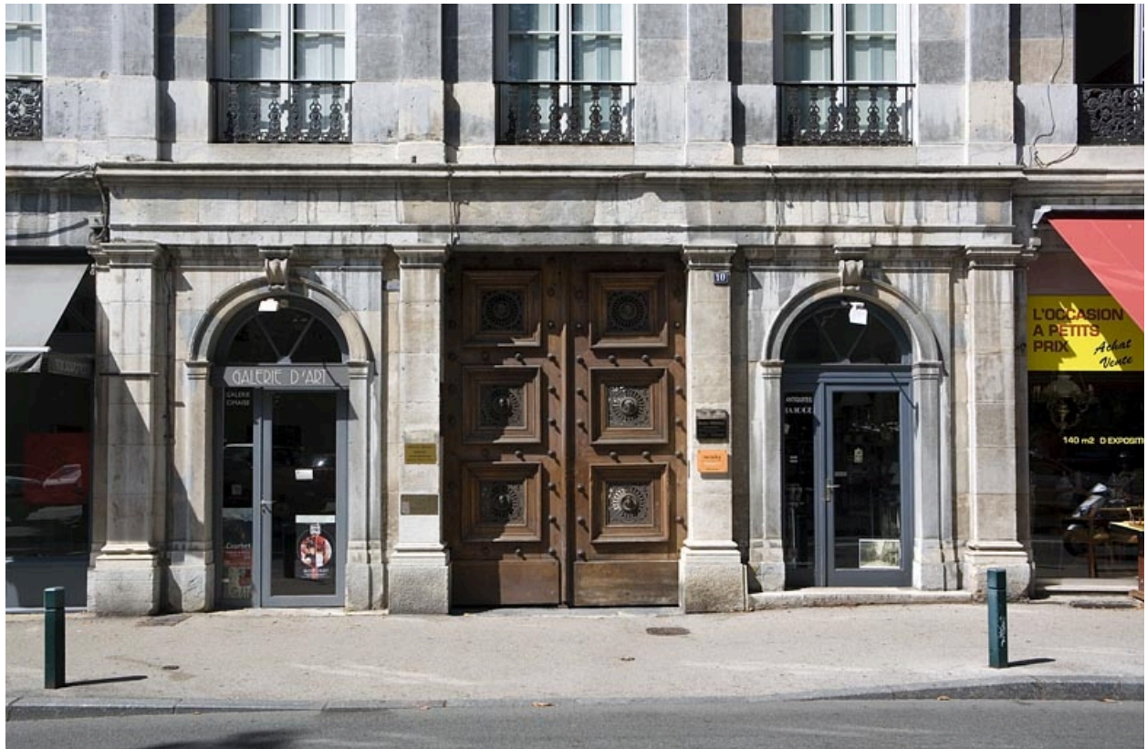
Façade sur rue : détail du portail d'entrée.
