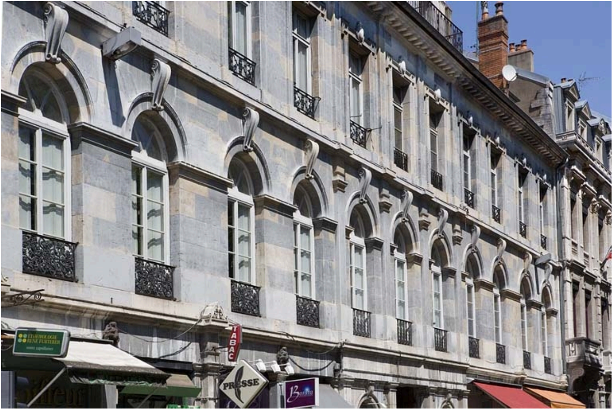
Façade sur rue : Vue d'ensemble du premier étage.
