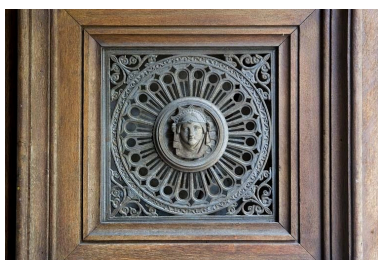
Détail du décor en fonte d'un des vantaux du portail d'entrée : tête de femme. Phot. Yves Sancey IVR43_20082500413NUC2A
