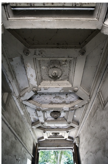
Détail du plafond du passage cocher depuis l'entrée. Phot. Yves Sancey IVR43_20082500416NUC2A
