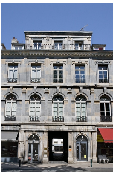
Vue d'ensemble de la partie centrale : façade sur rue.
