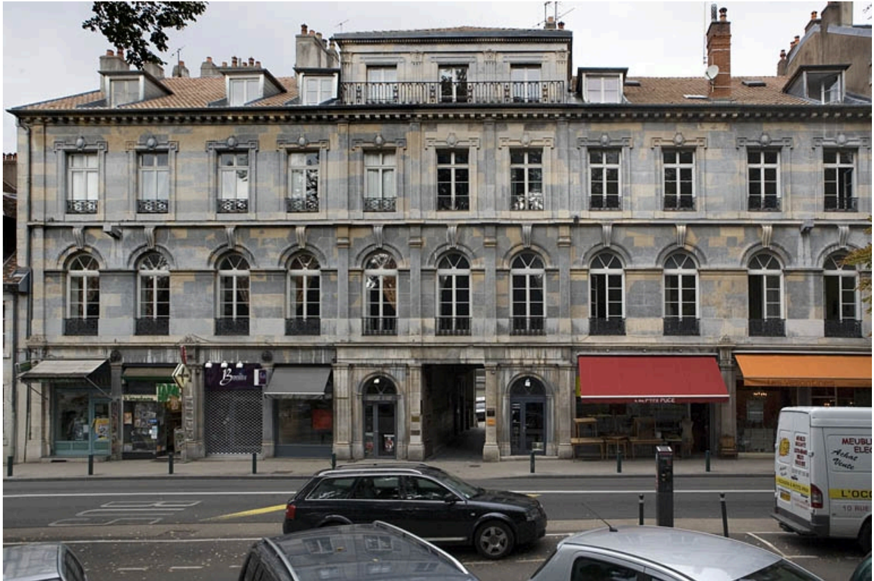
Vue d'ensemble de la façade sur rue, de face.
