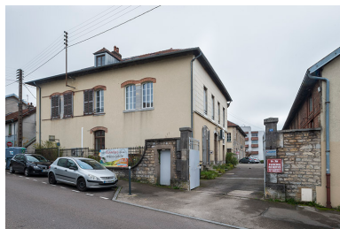
Vue depuis l'entrée. Phot. Jérôme Mongreville IVR43_20172501368NUC4A
