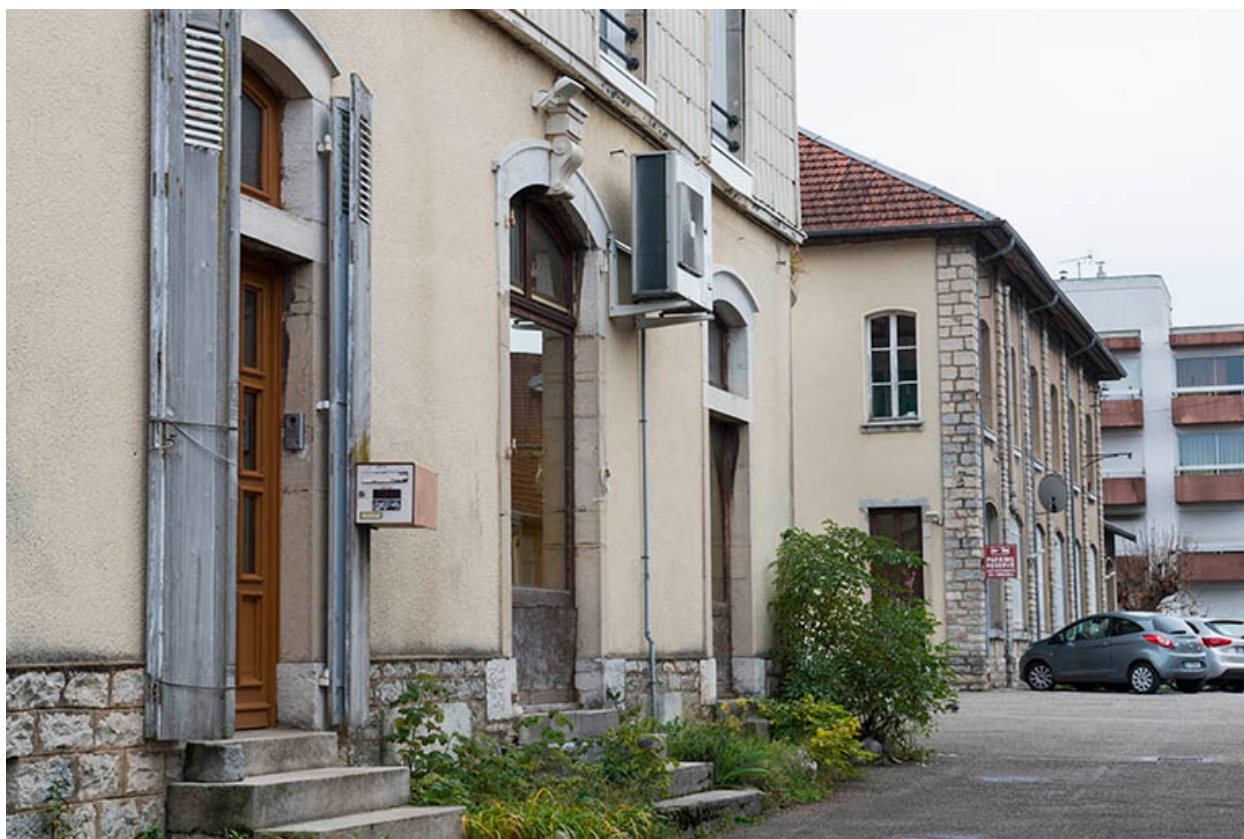
Vue depuis l'entrée. Logement et atelier.
