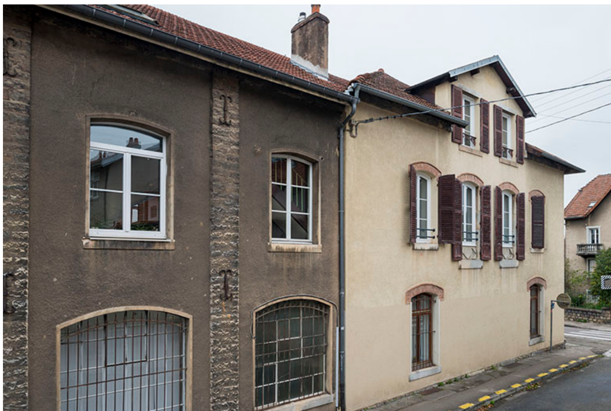
Façade du logement sur la rue Grenier.
