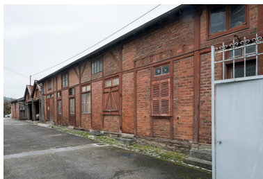
Les dépendances vues de trois quarts. Phot. Jérôme Mongreville IVR43_20172501366NUC4A
