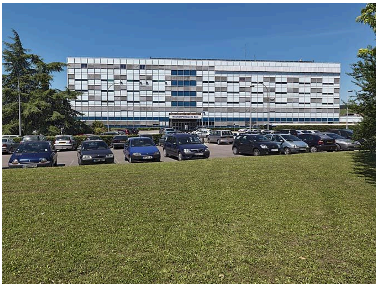
Bâtiment principal, façade.
