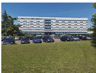
Bâtiment principal, façade. Phot. Thierry Kuntz IVR26_20102100948NUC4A
