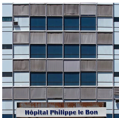
Bâtiment principal, détail de la façade. Phot. Thierry Kuntz IVR26_20102100959NUC2A
