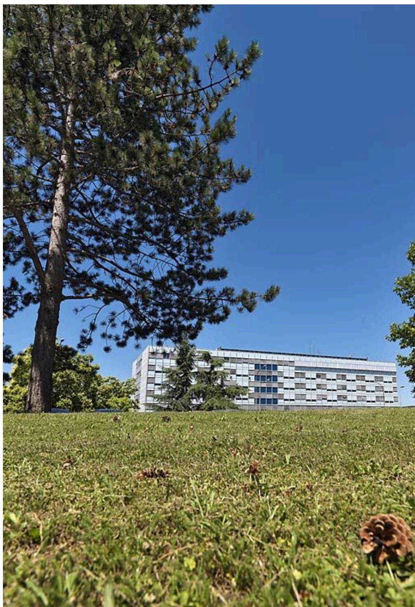
Bâtiment principal, vue d'ensemble.
