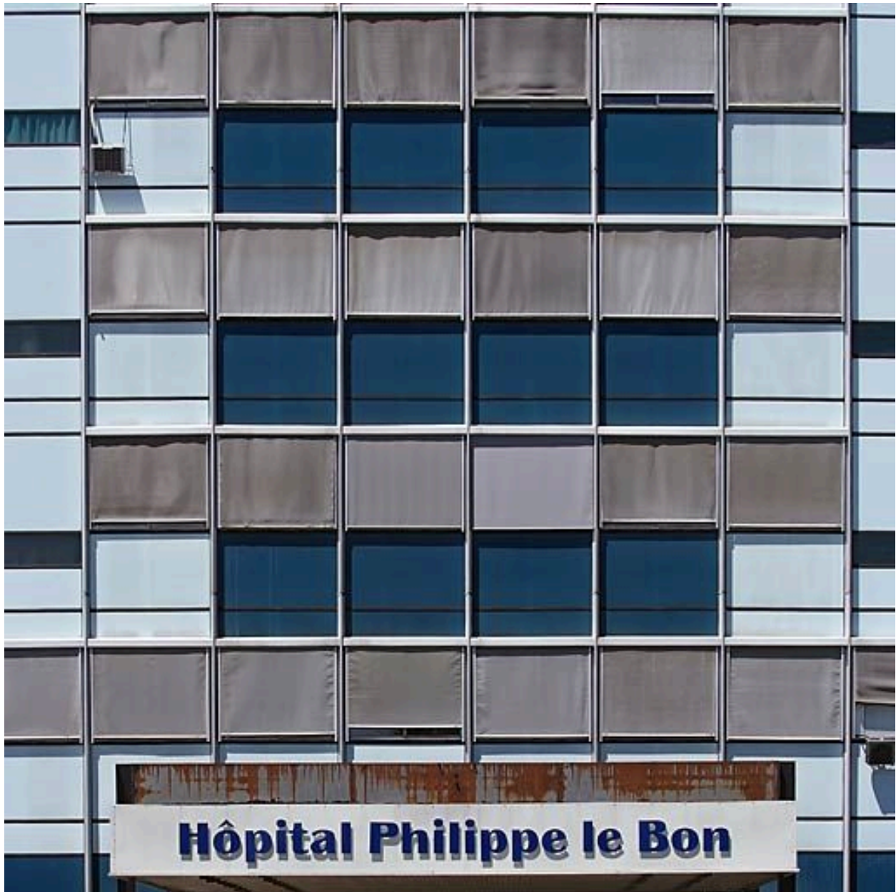
Bâtiment principal, détail de la façade.
