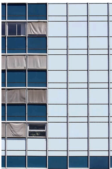
Bâtiment principal, détail. Phot. Thierry Kuntz IVR26_20102100966NUC2A
