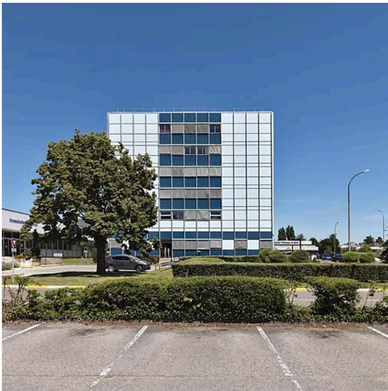
Bâtiment principal, élévation latérale.
