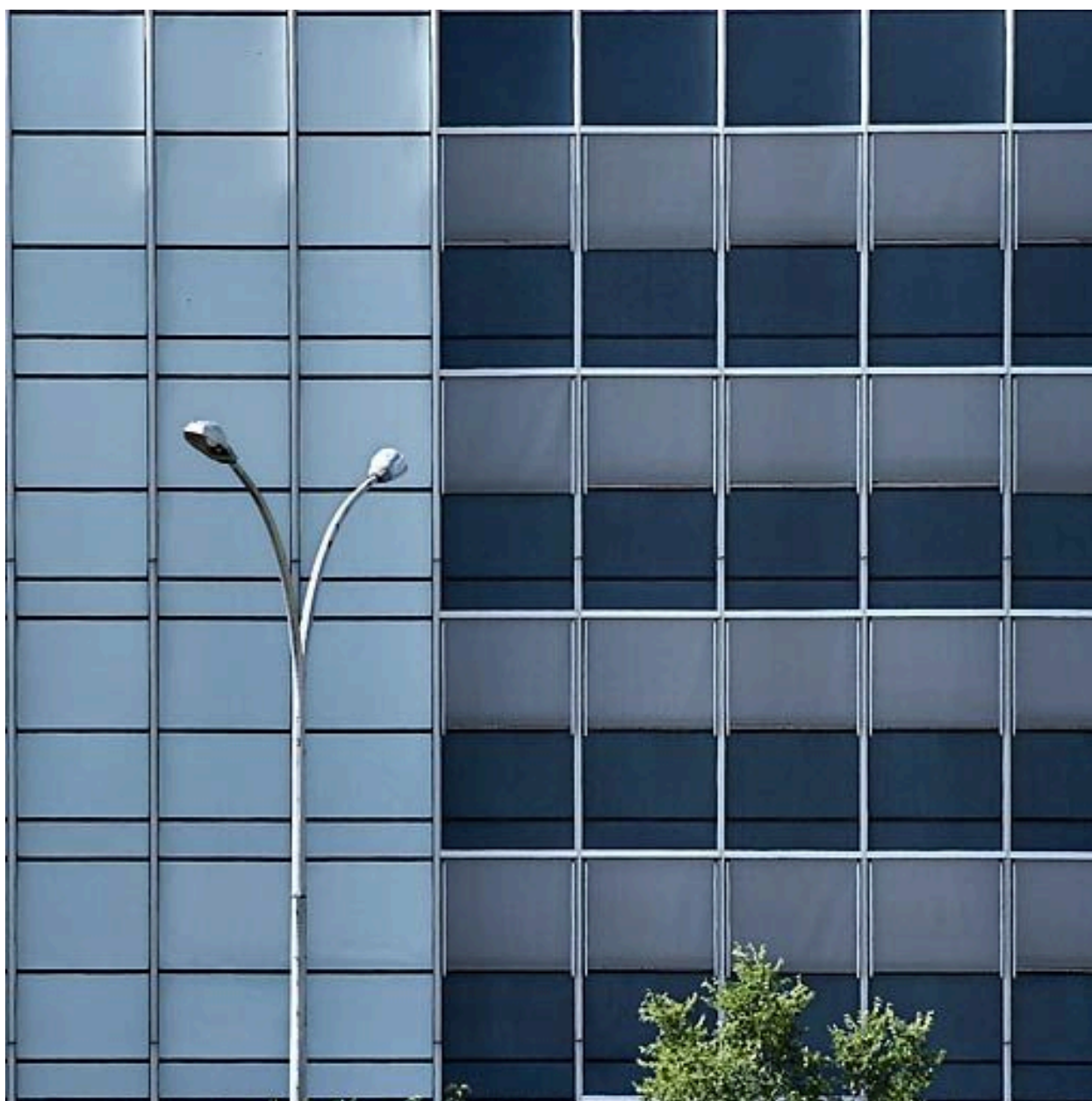
Bâtiment principal, détail.
