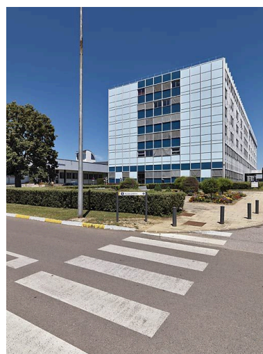
Bâtiment principal, vue d'ensemble de trois-quarts. Phot. Thierry Kuntz IVR26_20102100954NUC4A
