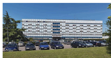
Bâtiment principal, façade. Phot. Thierry Kuntz IVR26_20102100947NUC4A
