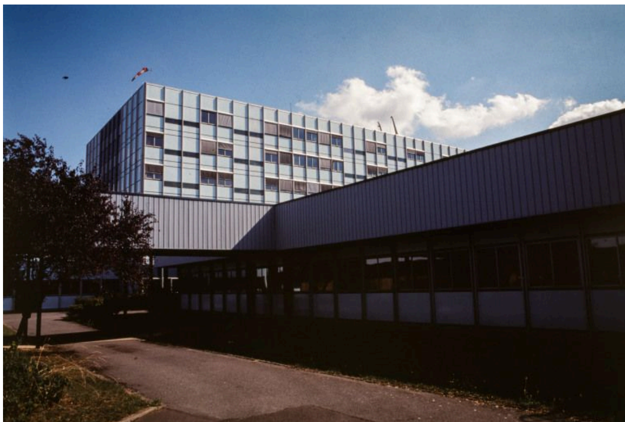
Bâtiment principal et galerie.
