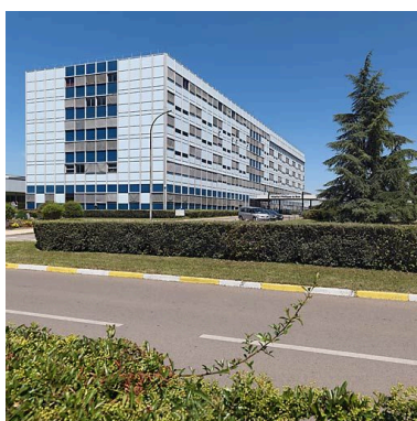
Bâtiment principal, vue d'ensemble de trois-quarts. Phot. Thierry Kuntz IVR26_20102100953NUC4A
