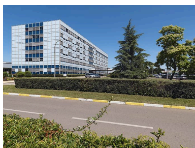
Bâtiment principal, vue d'ensemble de trois-quarts. Phot. Thierry Kuntz IVR26_20102100952NUC4A
