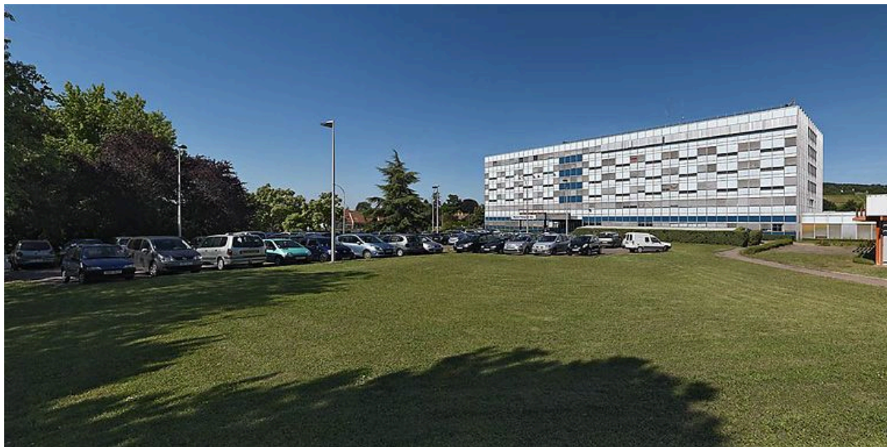
Bâtiment principal, vue d'ensemble.
