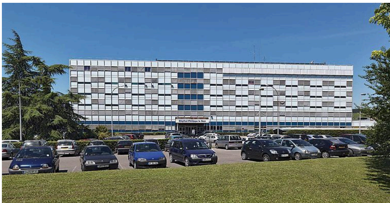
Bâtiment principal, façade.
