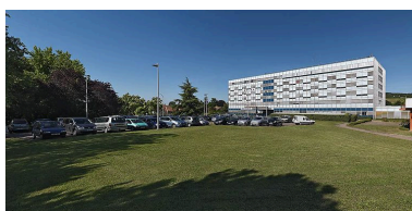
Bâtiment principal, vue d'ensemble. Phot. Thierry Kuntz IVR26_20102100945NUC4AQ
