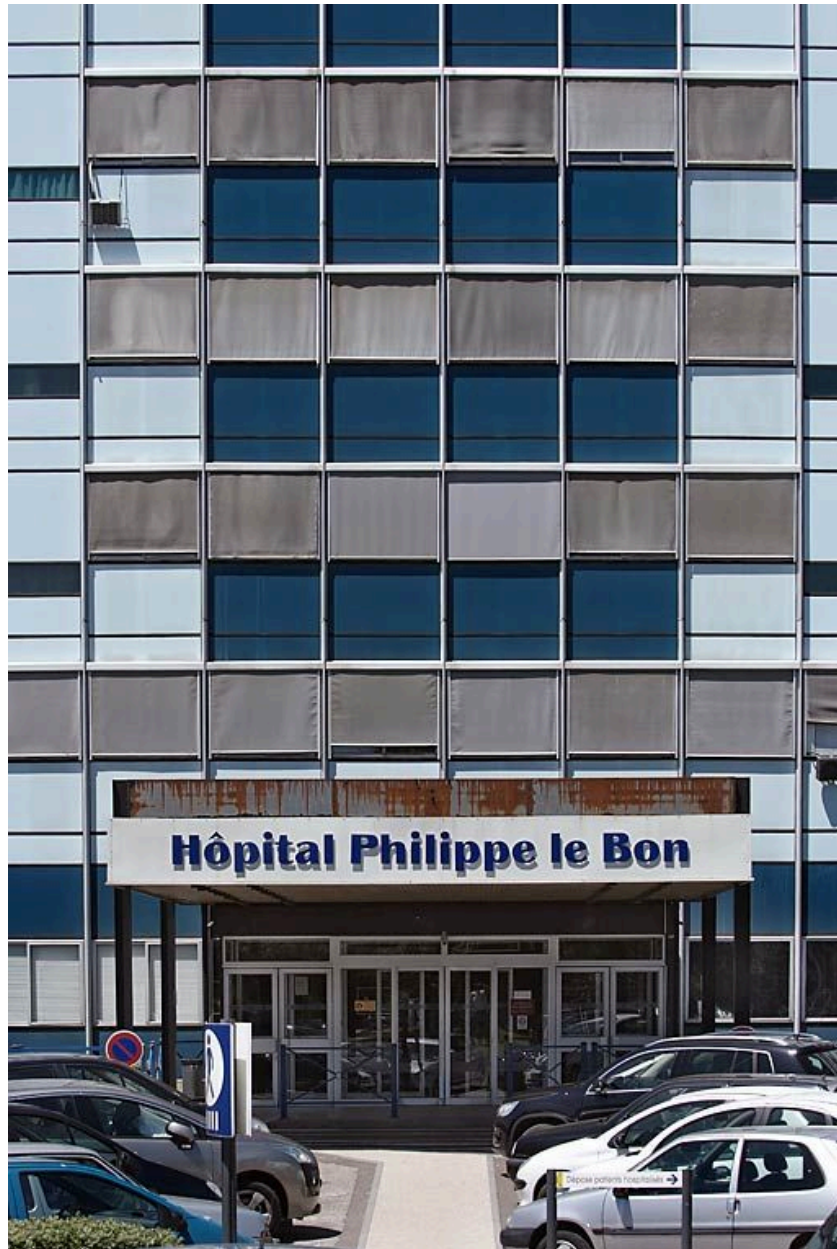
Bâtiment principal, détail de la façade.
