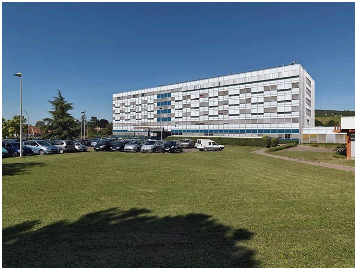
Bâtiment principal, vue d'ensemble.
