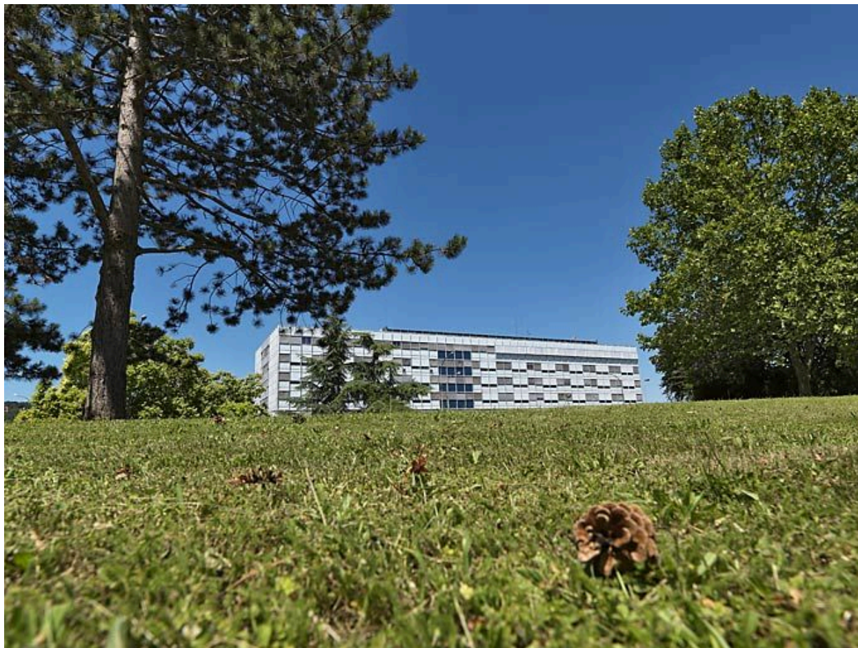
Bâtiment principal, vue d'ensemble.
