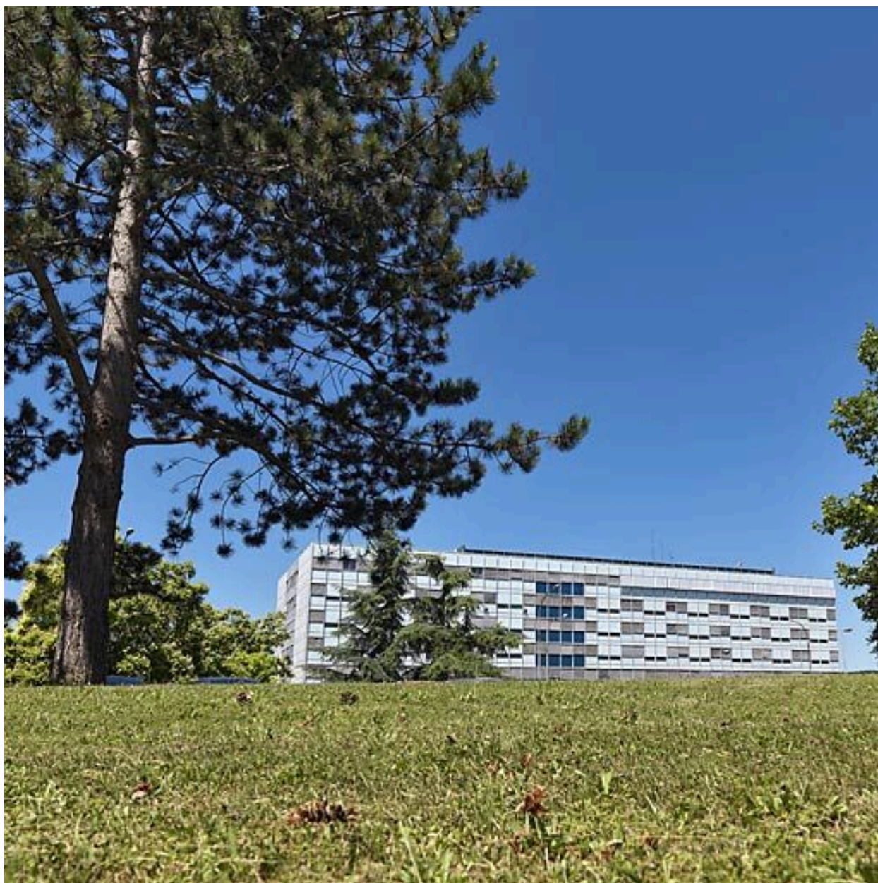
Bâtiment principal, vue d'ensemble.
