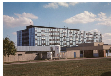
Vue générale en 2001. Phot. Jean-Luc Duthu IVR26_20012100954ZA
