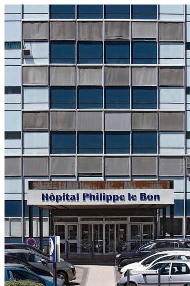
Bâtiment principal, détail de la façade. Phot. Thierry Kuntz IVR26_20102100960NUC2A
