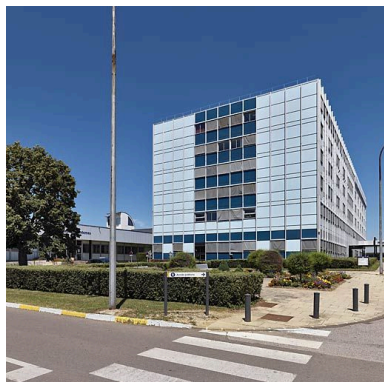
Bâtiment principal, vue d'ensemble de trois-quarts. Phot. Thierry Kuntz IVR26_20102100955NUC4A
