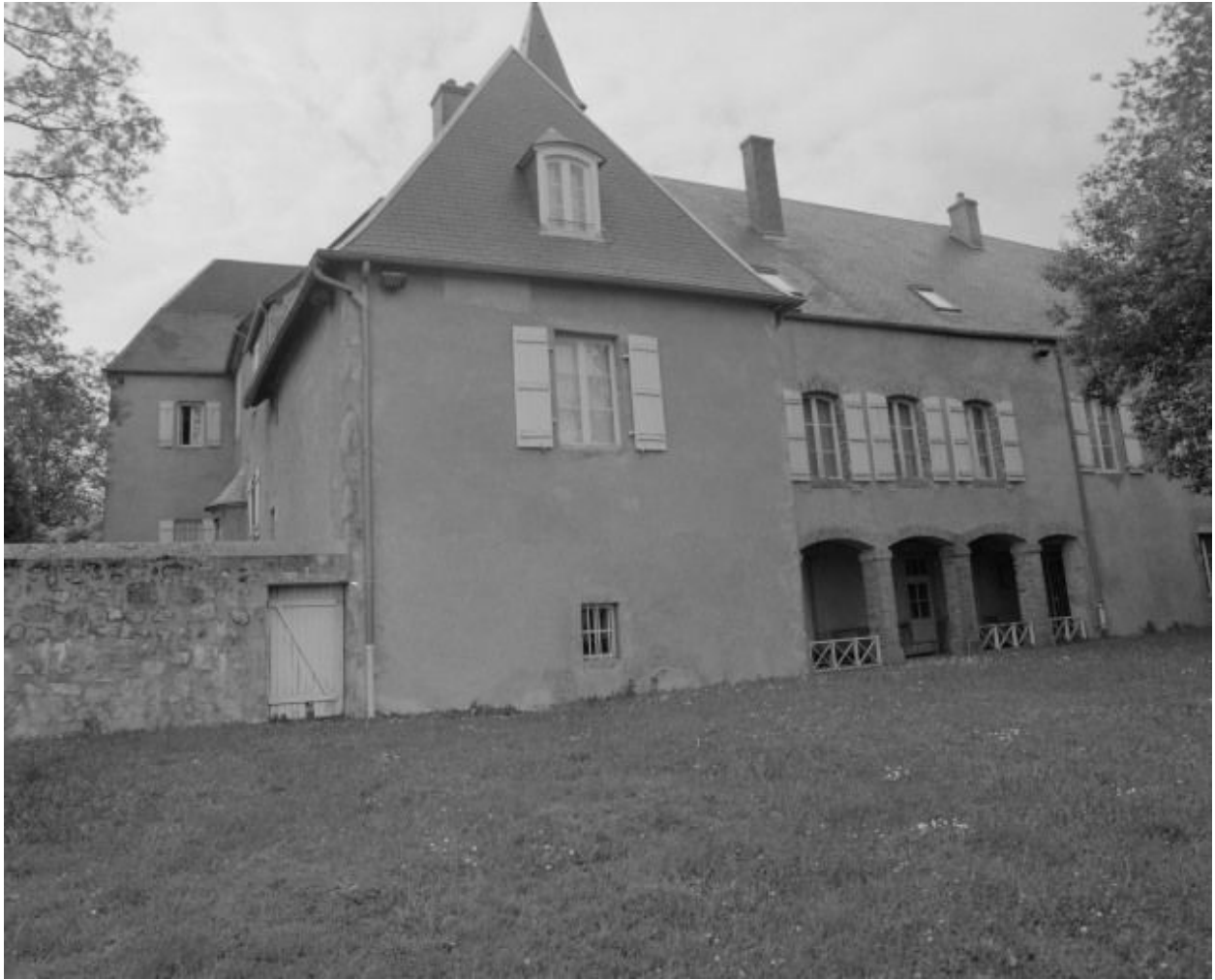
Vue d'ensemble de la façade postérieure.
