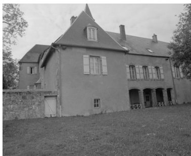
Vue d'ensemble de la façade postérieure. Phot. Jean-Luc Duthu IVR26_20035800223X
