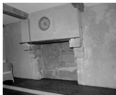
Vue d'ensemble d'une cheminée. Phot. Jean-Luc Duthu IVR26_20035800227X
