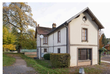
Vue depuis le sud-ouest. Phot. Jérôme Mongreville IVR43_20207000719NUC4A
