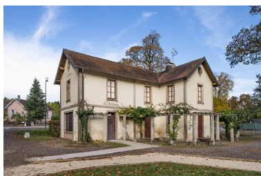
Vue depuis le sud-est. Phot. Jérôme Mongreville IVR43_20207000717NUC4A
