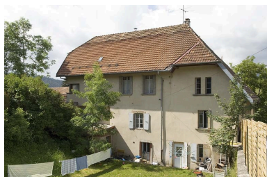
Façade postérieure. Phot. Jérôme Mongreville IVR43_20092500791NUC2A
