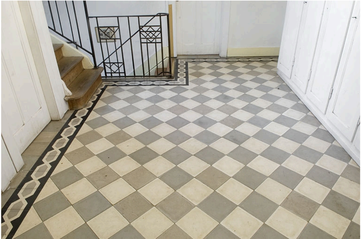
Intérieur : pavement du premier étage de l'aile en retour (1933).
