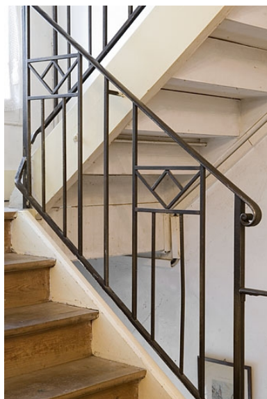
Intérieur : détail de la rampe d'appui de l'escalier menant aux étages de l'aile en retour (1933).
