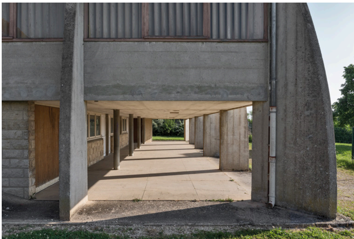
Galerie sous l'église et accès aux salles paroissiales. Vue depuis le sud.
