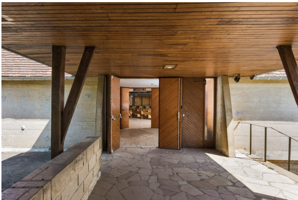
Entrée de l'église. Vue sous le porche.
