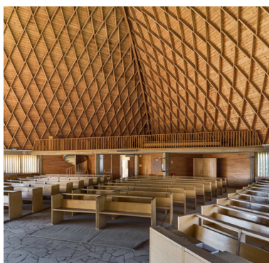
Entrée et tribune. Vue depuis le chœur. Phot. Pierre-Marie Barbe-Richaud IVR26_20258900064NUC4A
