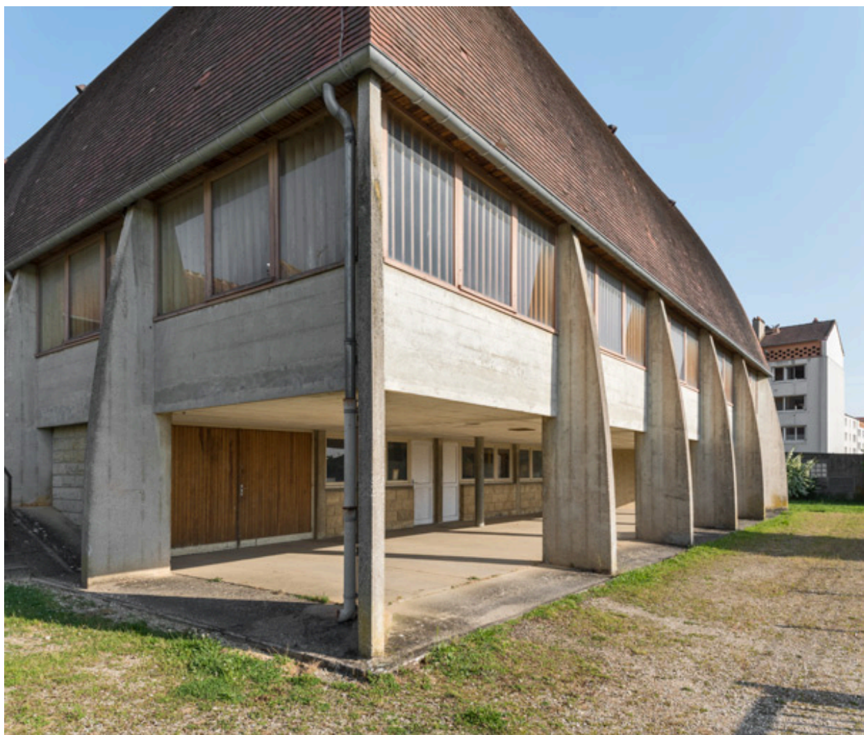
Galerie et salles paroissiales. Vue de trois quarts.
