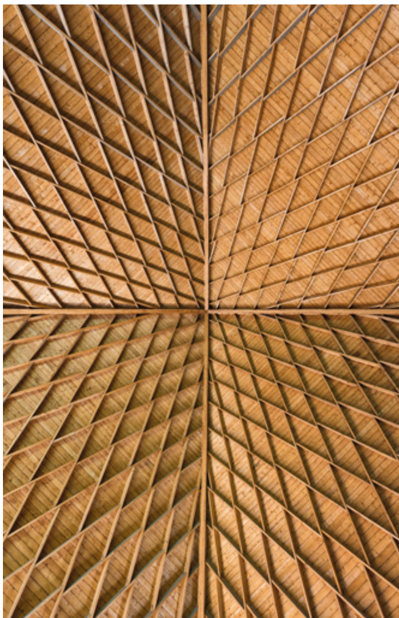
Charpente. Vue en contre-plongée.
