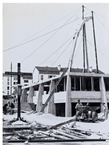
Église Sainte-Thérèse en construction, 1958.
