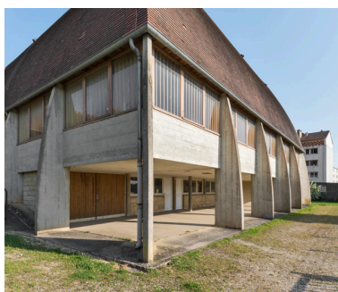
Galerie et salles paroissiales. Vue de trois quarts. Phot. Pierre-Marie Barbe-Richaud IVR26_20258900076NUC4A
