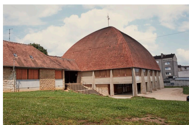
Vue d'ensemble de trois- quarts gauche, 2000. Phot. Jean-Luc Duthu IVR26_20008900131ZA
