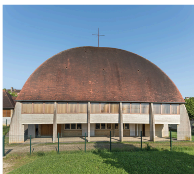
Eglise, galerie et salles paroissiales. Vue d'ensemble. Phot. Pierre-Marie Barbe-Richaud IVR26_20258900077NUC4A
