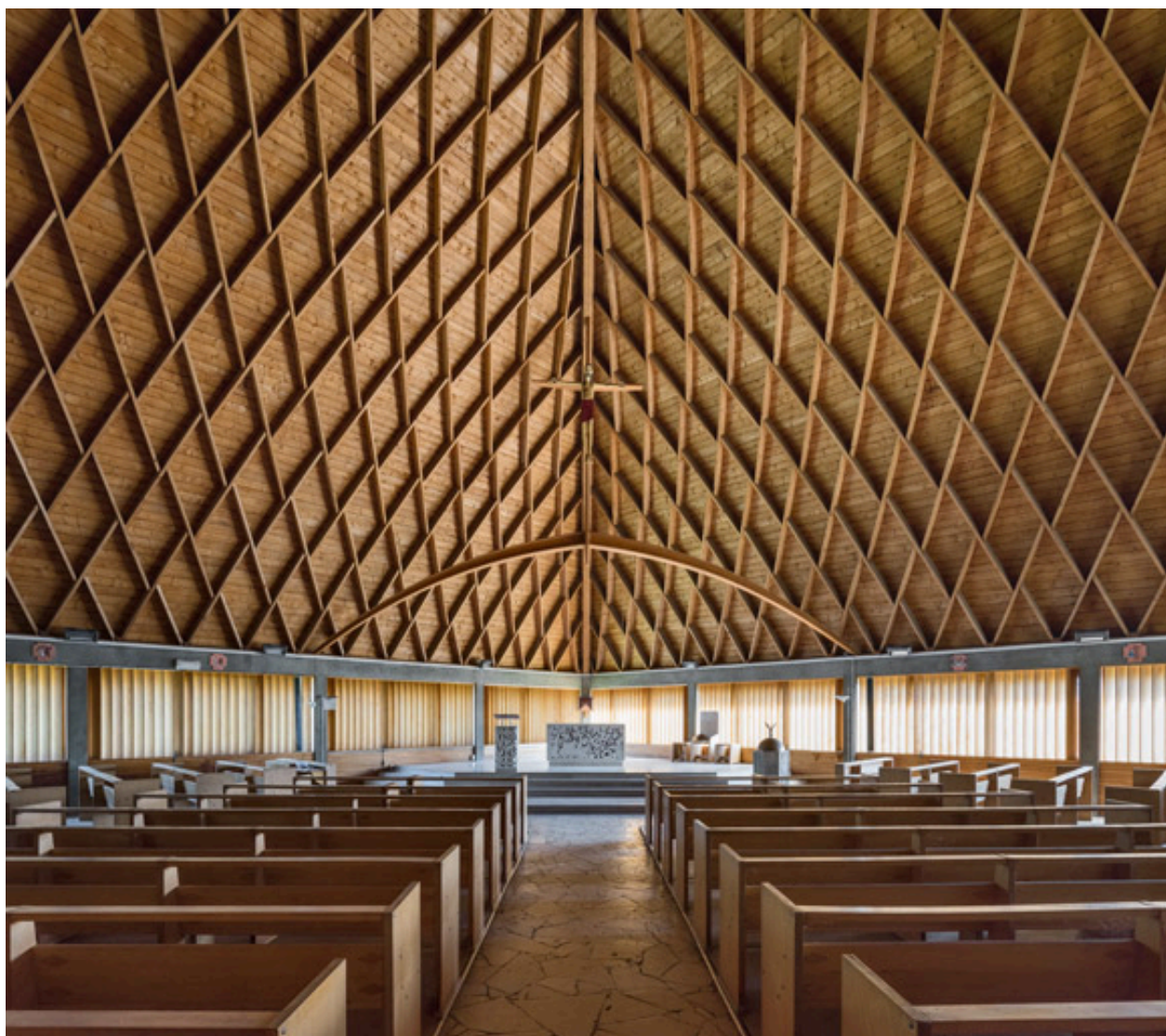
Chœur. Vue depuis l'allée centrale.
