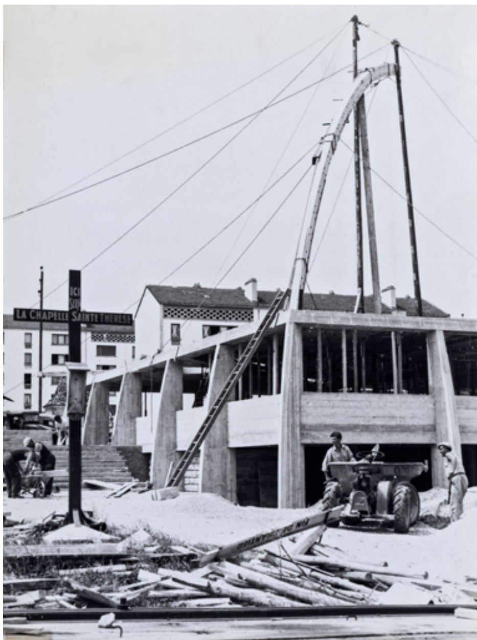
Église Sainte-Thérèse en construction, 1958.
