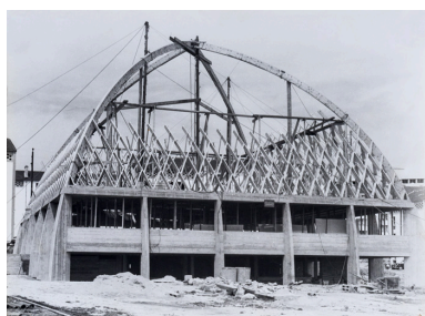
Pose de la charpente de l'église Sainte-Thérèse des Rosoirs, 1958. Phot. Pierre-Marie Barbe- Richaud, Autr. auteur inconnu IVR26_20238900730NUC2A
