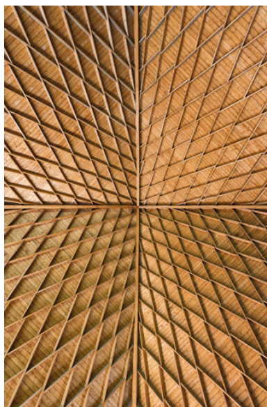
Charpente. Vue en contre-plongée. Phot. Pierre-Marie Barbe-Richaud IVR26_20258900070NUC4A
