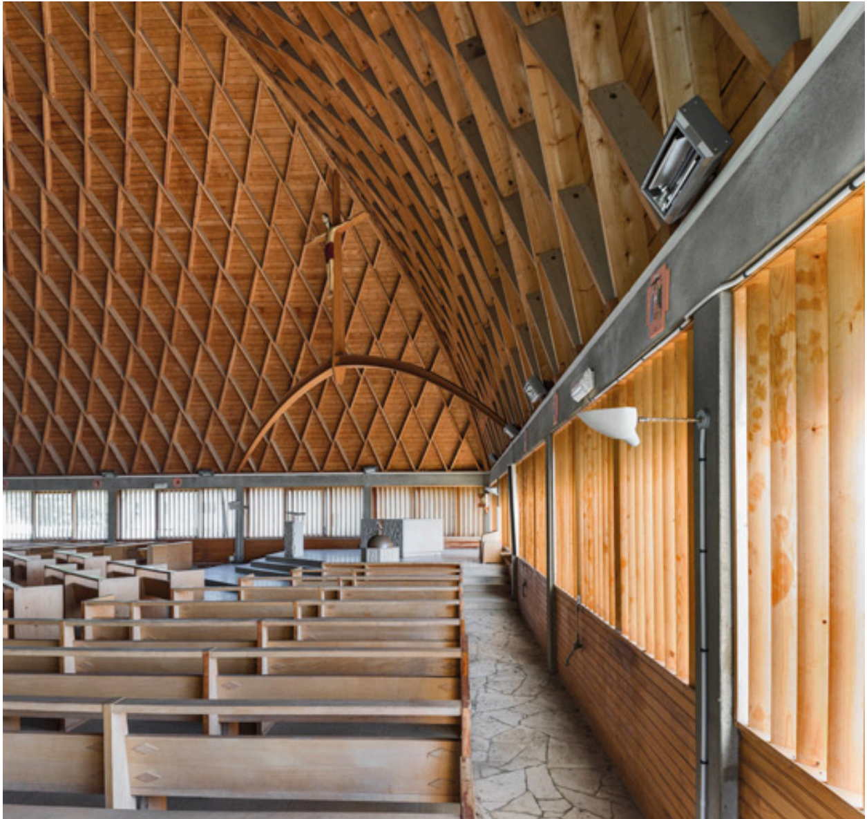
Nef. Vue depuis l'angle sud en direction du chœur.
