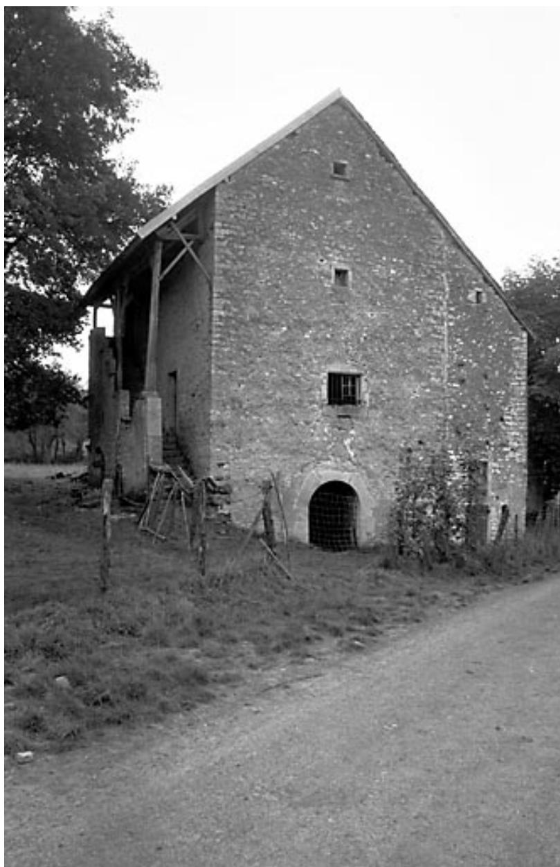
Façades antérieure et latérale droite.
