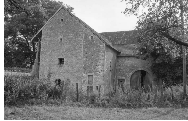
Façades sur rue. Phot. Bernard Lardière IVR43_19797000244Z
