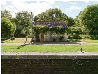
VUE du sas et de la maison éclusière.
