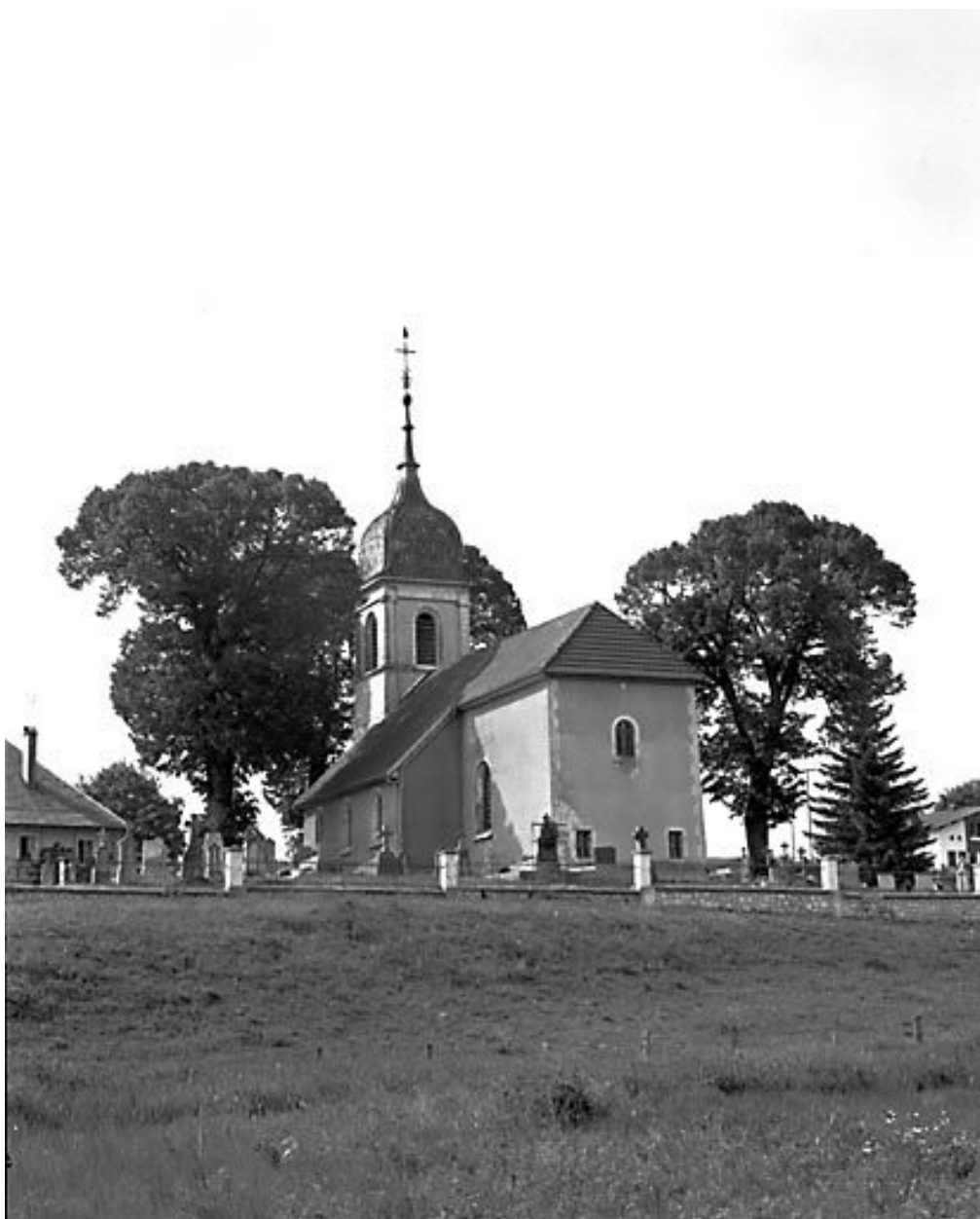
Vue depuis le sud-est.
