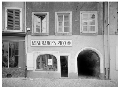
Façade sur la rue de Belfort. Phot. Jérôme Mongreville IVR43_19882500107V
