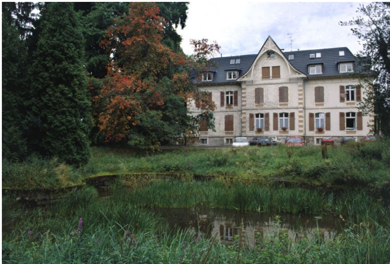
Vue d'ensemble du logement patronal.
