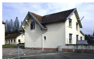
Bureaux et conciergerie. Phot. Yves Sancey IVR43_19999000332ZA
