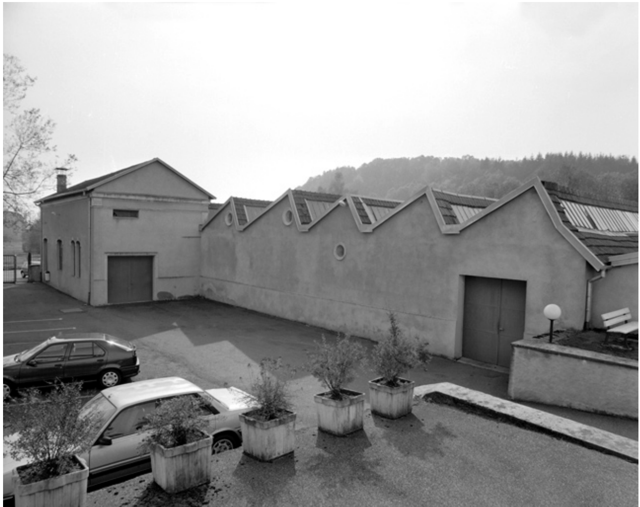
Atelier de fabrication (?) depuis les bureaux.
