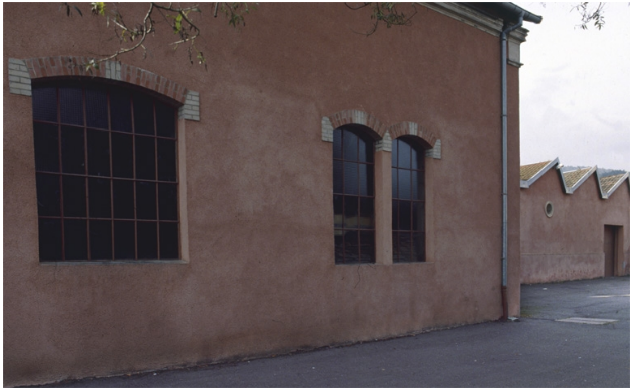
Détail de baies.
