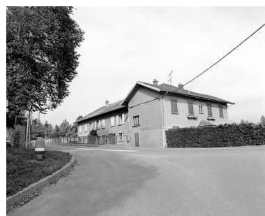
Logement d'ouvriers. Phot. Yves Sancey IVR43_19999000325X
