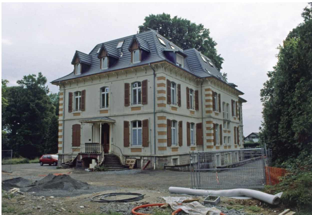
Logement patronal depuis le nord-ouest.
