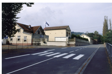
Vue d'ensemble depuis la rue des Prés-Heyd. Phot. Yves Sancey IVR43_19999000328ZA
