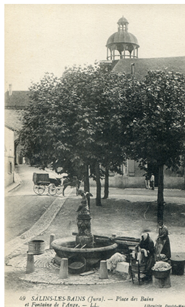
Salins-les-Bains (Jura) - Place des Bains et fontaine de l'Ange, s.d. [fin 19e ou début 20e siècle]. Phot. auteur inconnu IVR43_20243900188NUC4A
