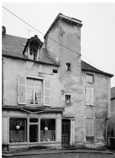
Vue de la maison sise parcelle 382, section AB sur le cadastre de 1965. Phot. Michel Rosso IVR26_19802100241V
