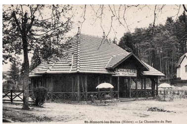
Vue ancienne. Autr. auteur inconnu IVR26_20245800639NUC4A
