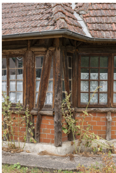
Détail de la façade. Phot. Pierre-Marie Barbe-Richaud IVR26_20195800392NUC4A
