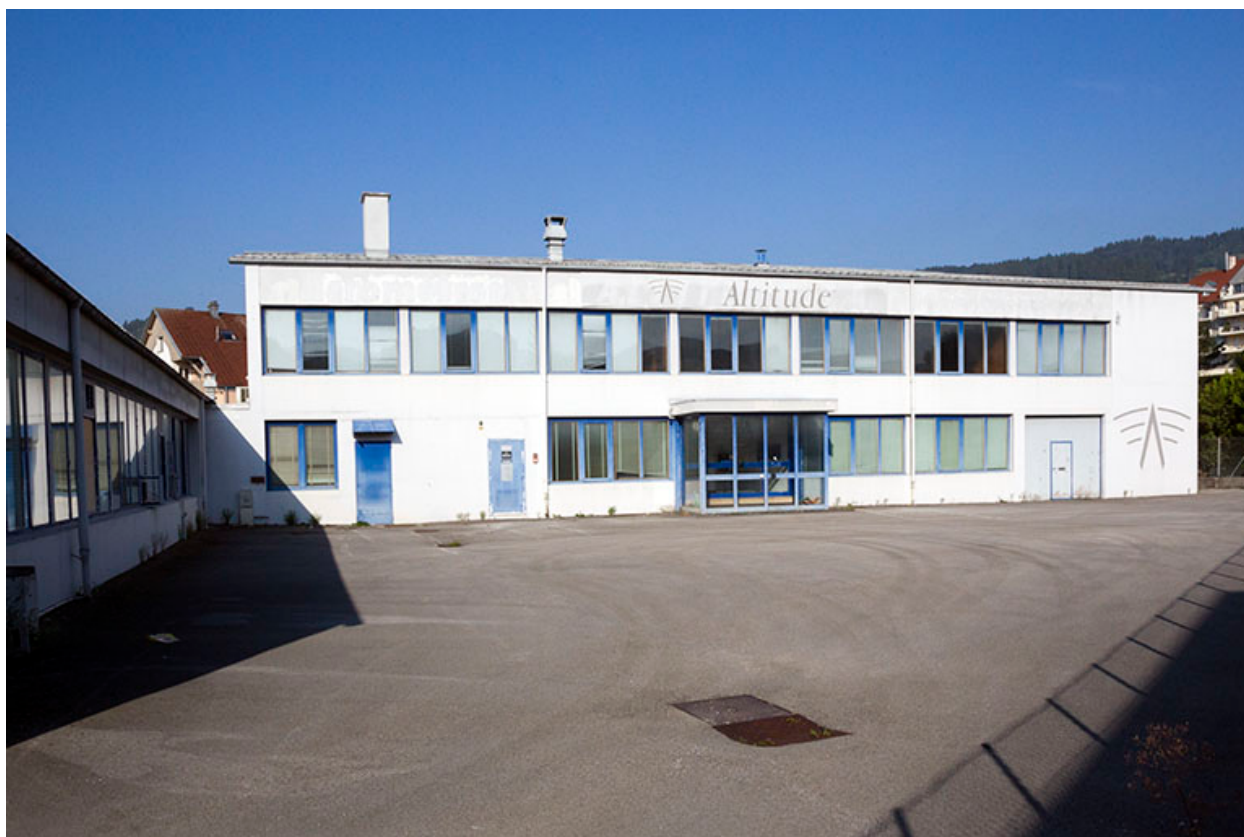
Bâtiment à étage : façade orientale.
