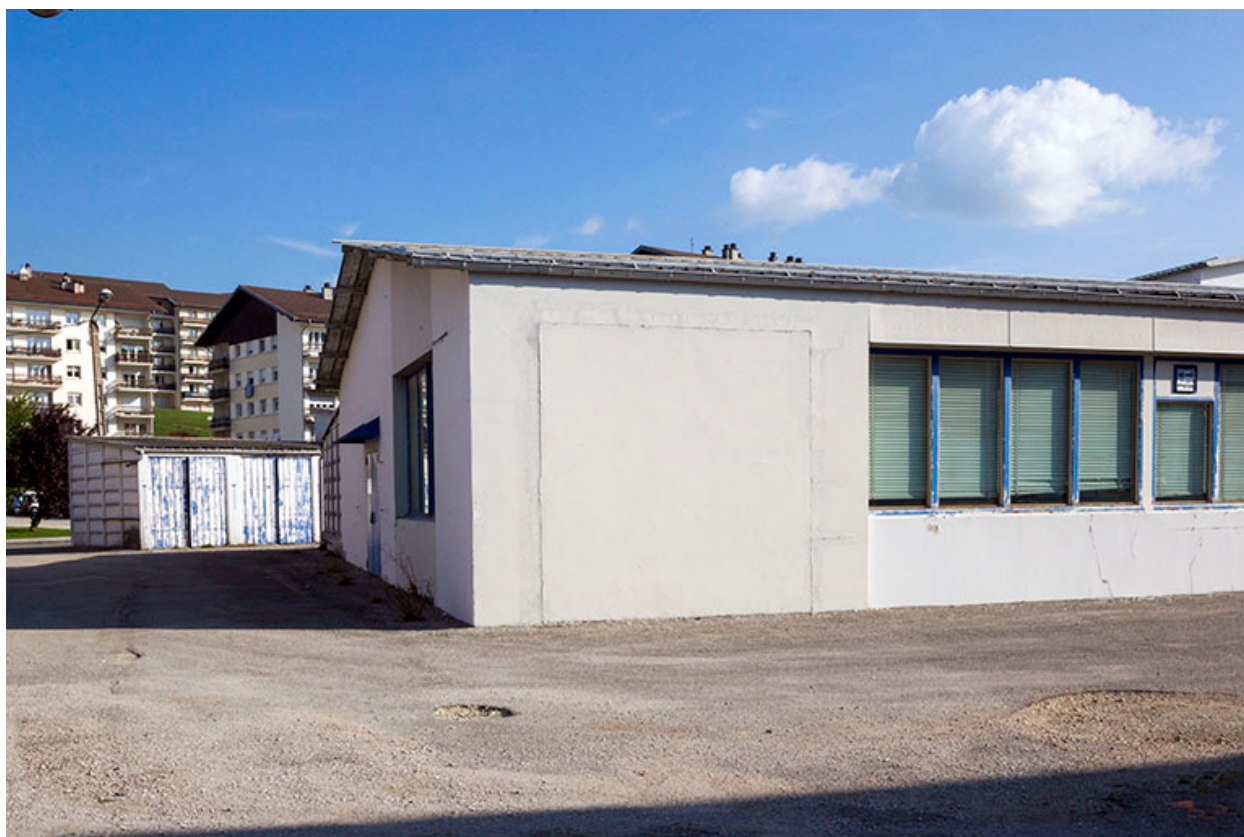
Bâtiment en rez-de-chaussée : extrémité occidentale.
