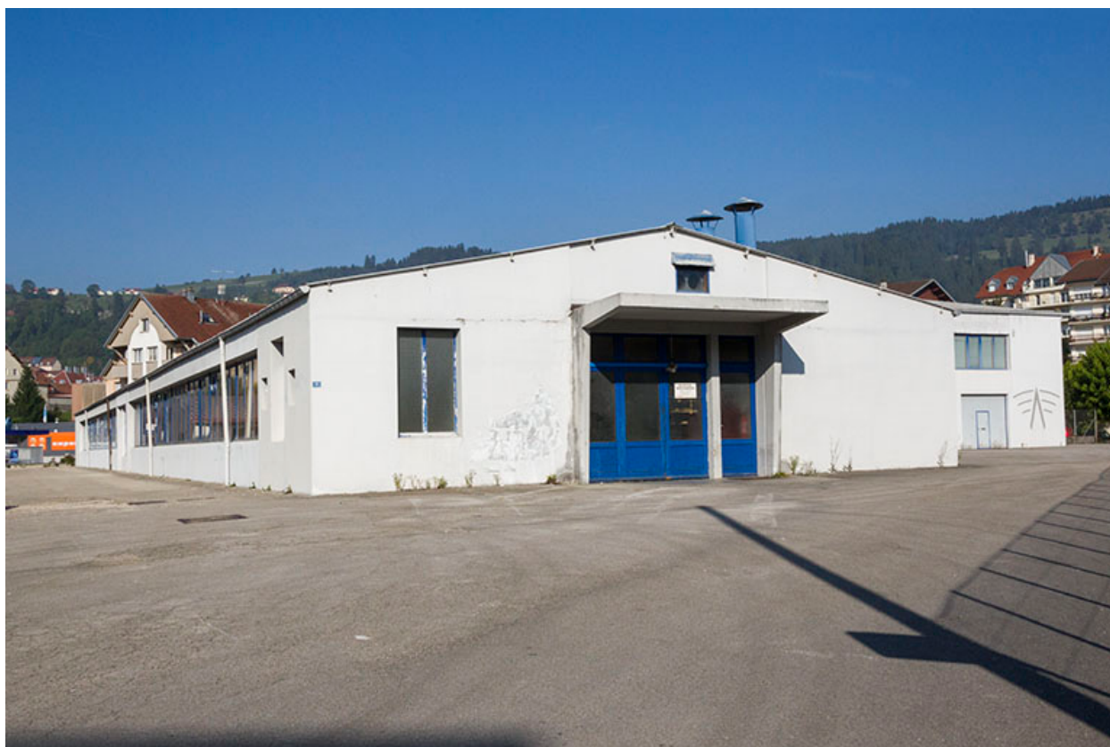
Bâtiment en rez-de-chaussée : extrémité orientale.
