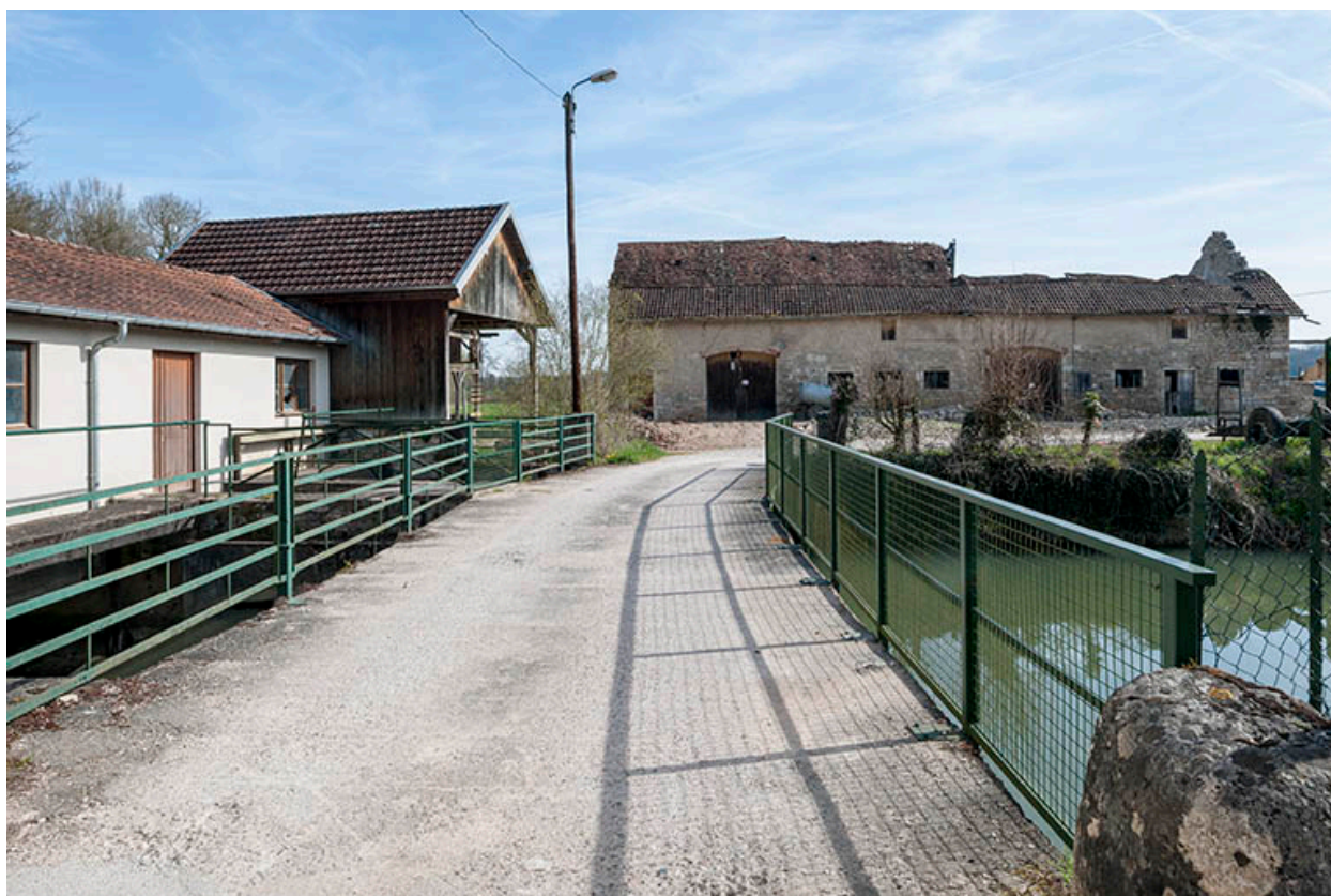
Centrale hydroélectrique (à gauche) et bâtiment agricole.
