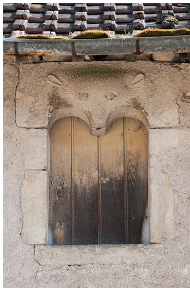
Détail d'une fenêtre du premier étage. Phot. Jérôme Mongreville IVR43_20152501101NUC4A
