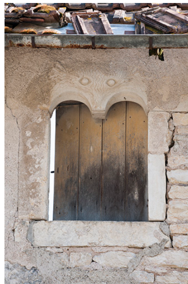
Détail d'une fenêtre du premier étage. Phot. Jérôme Mongreville IVR43_20152501102NUC4A
