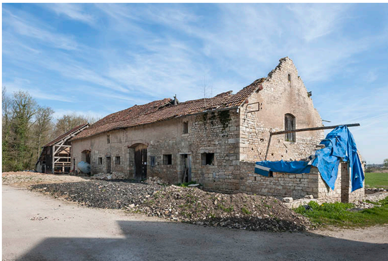
Bâtiment agricole vu de trois quarts droite.
