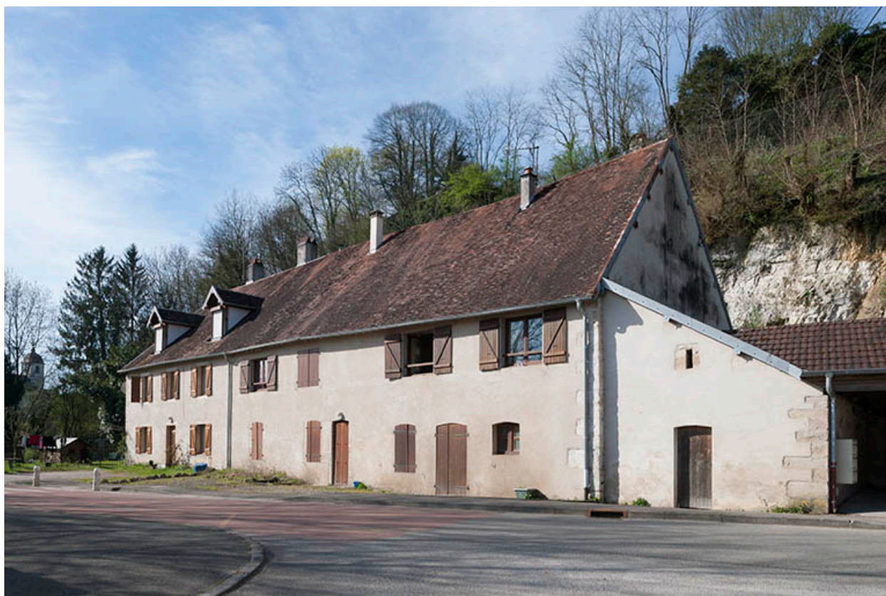
Logement ouvrier (11-13 route d'Emagny).
