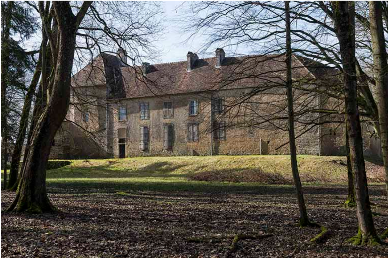
Façade est du château.
