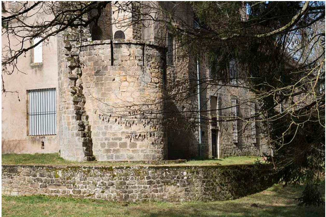
Détail sur la maçonnerie de la tour.
