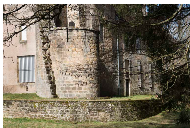
Détail sur la maçonnerie de la tour. Phot. Jérôme Mongreville IVR43_20177000119NUC4A
