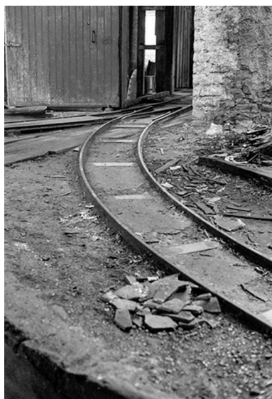
Voie Decauville à l'entrée d'un atelier en 1979.
