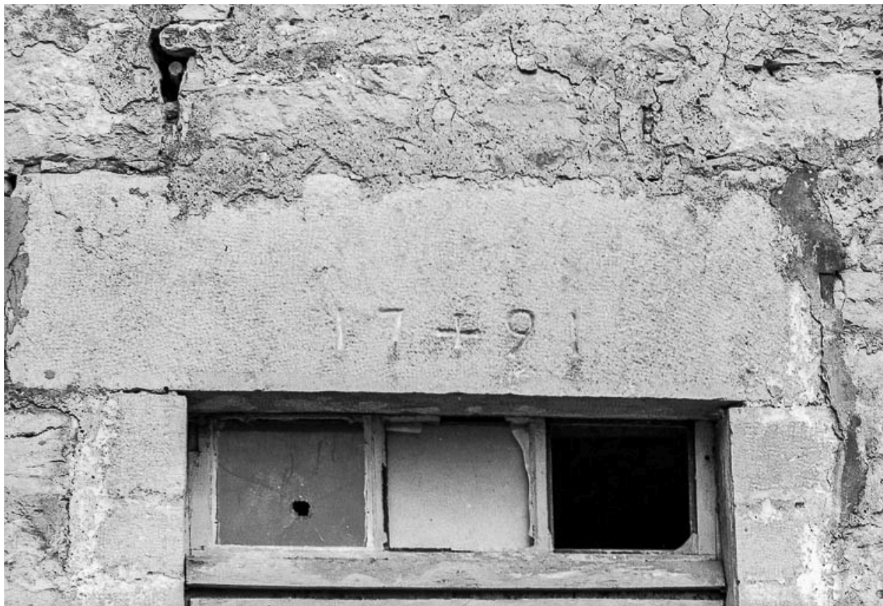
Ancien logement patronal (dispensaire en 1979). Détail du linteau.
