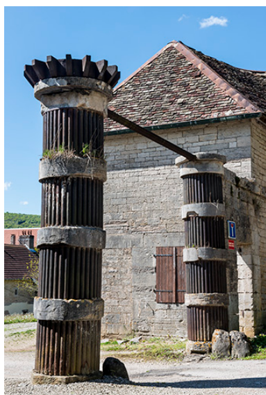
Détail des piliers. Phot. Jérôme Mongreville IVR43_20172500644NUC4A
