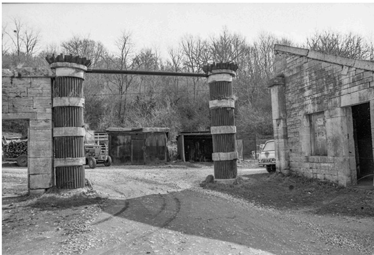
Portail de l'usine, depuis la cour, en 1979.
