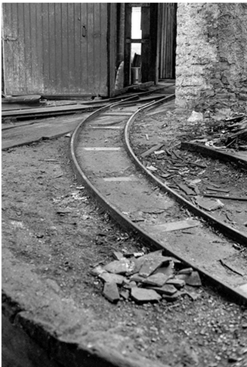
Voie Decauville à l'entrée d'un atelier en 1979.
