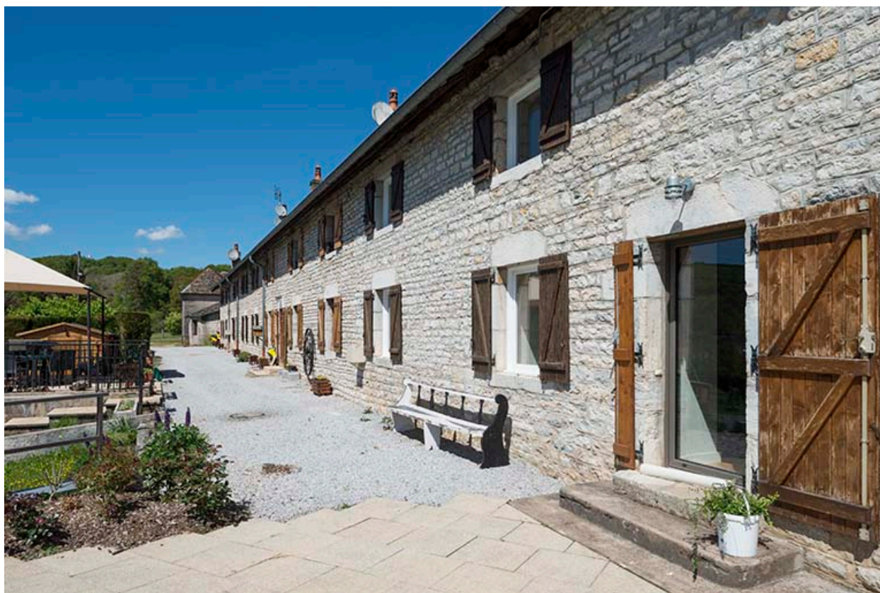
Logement ouvrier. Façade antérieure de l'aile sud.
