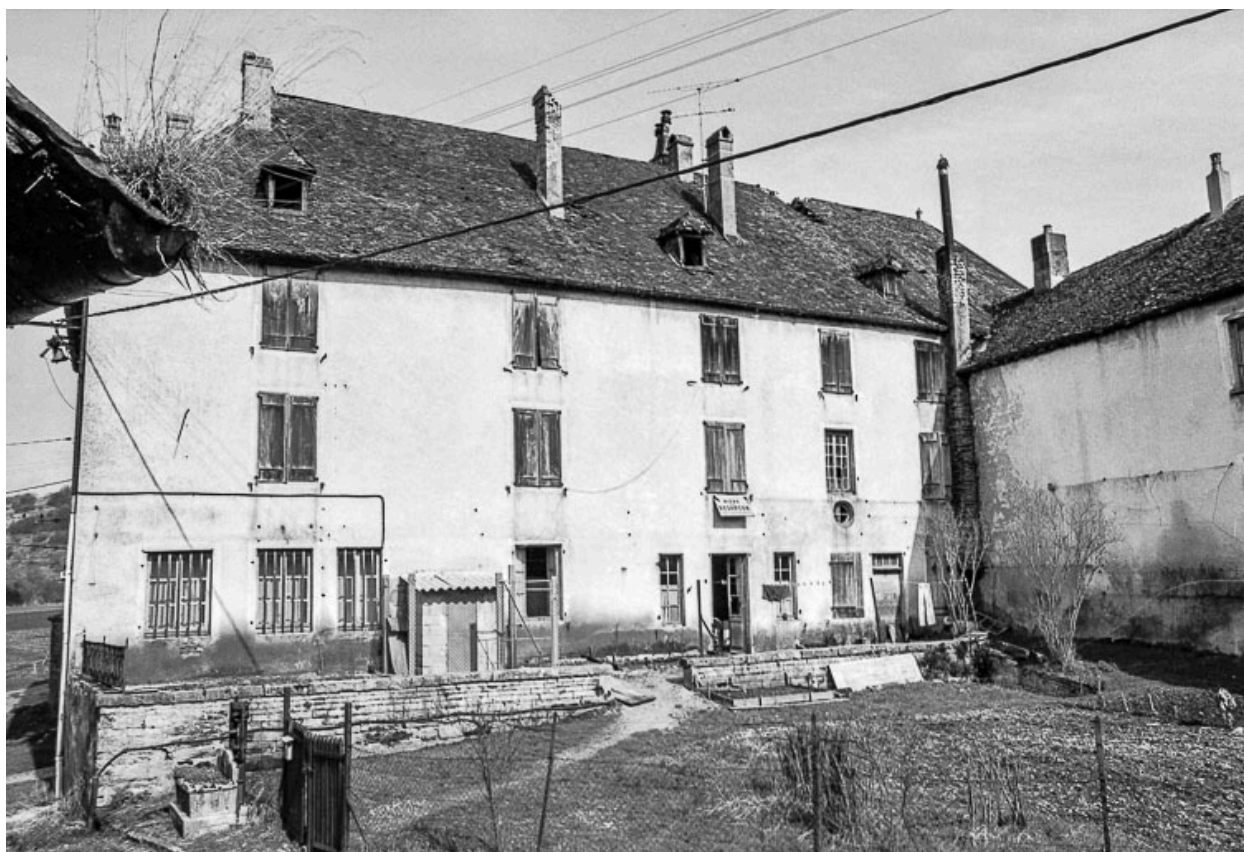
Logement ouvrier, bureau et dispensaire en 1979.
