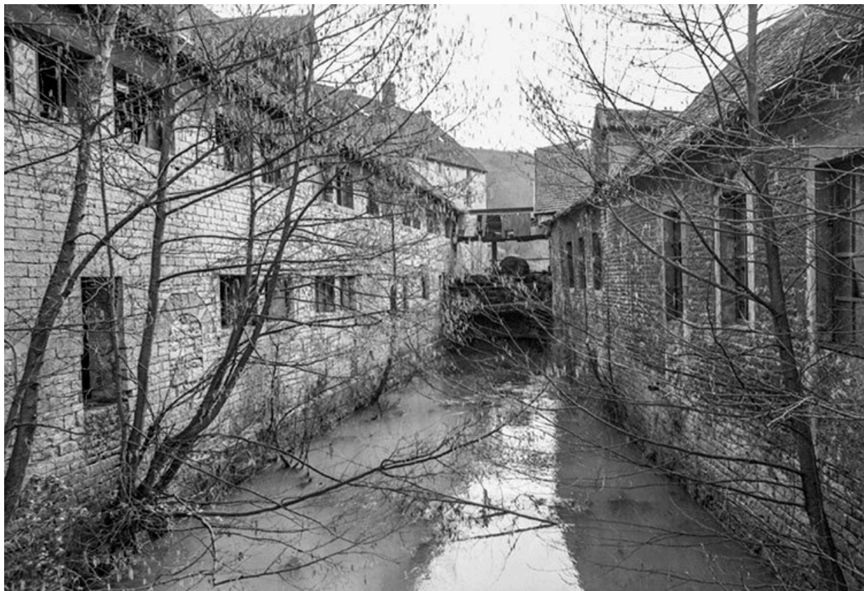
Bief de dérivation entre les ateliers en 1979.
