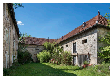
Remise et écurie. Phot. Jérôme Mongreville IVR43_20172500642NUC4A
