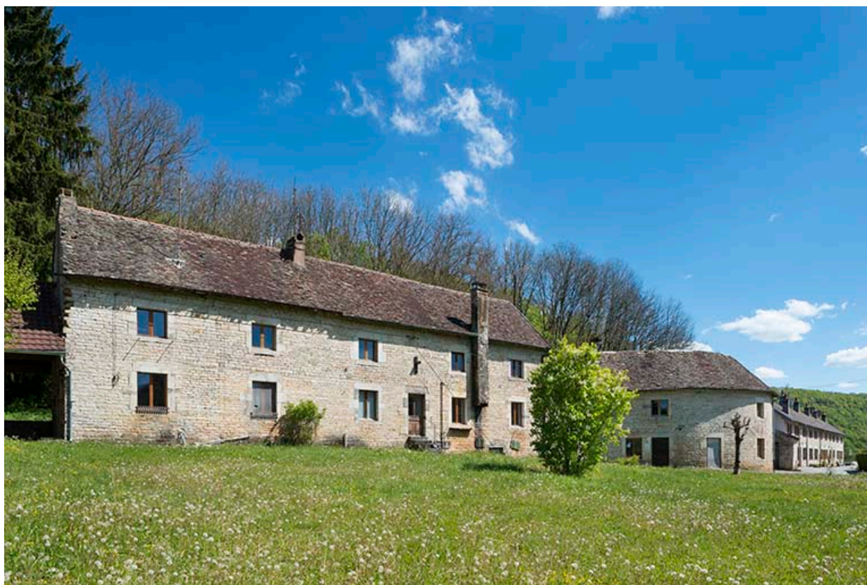
Logements ouvriers encadrant l'entrée de l'usine.
