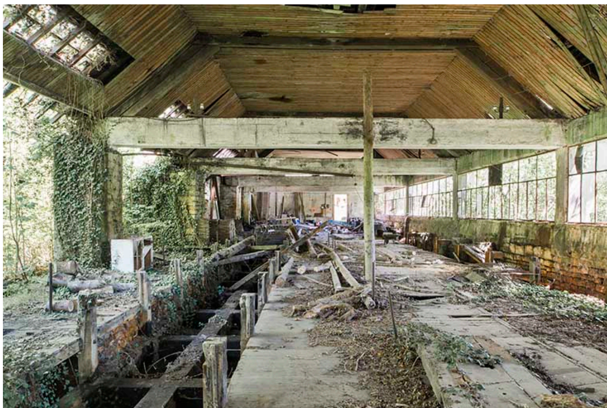
Atelier de tréfilerie. Vue intérieure depuis l'ouest.
