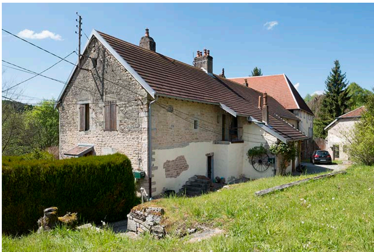
Logement patronal (maison du maître de forges).
