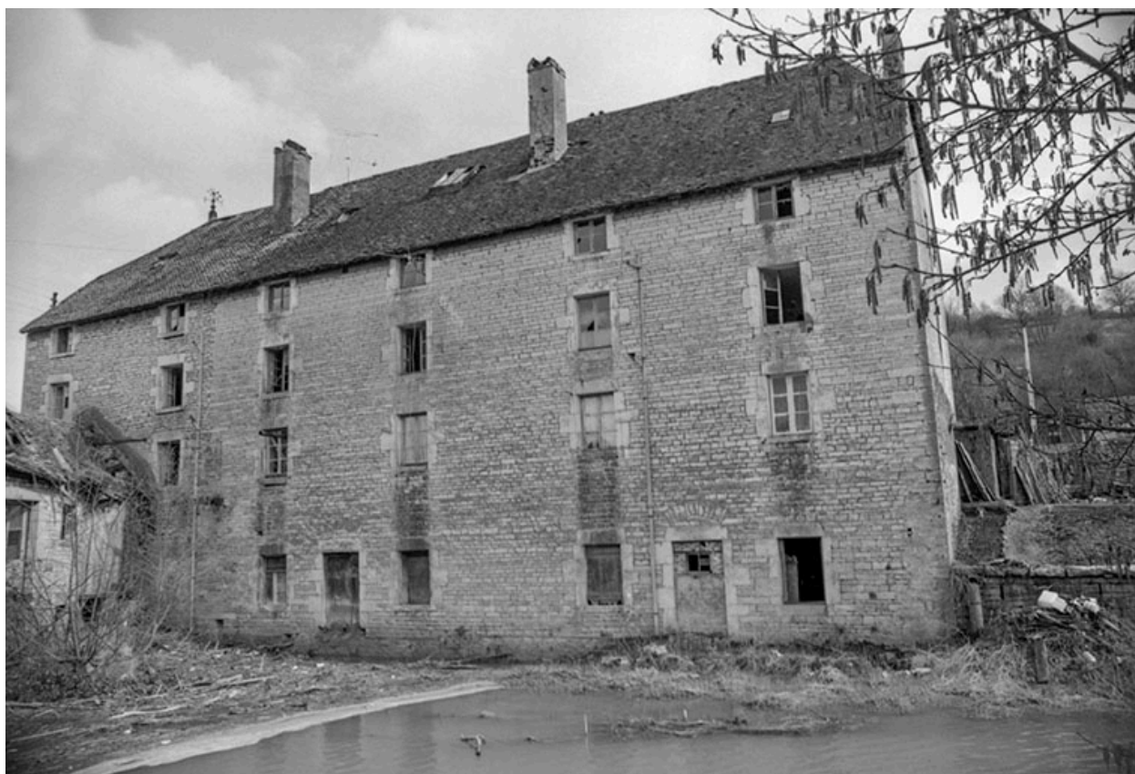
Logement ouvrier. Façade ouest en 1979.
