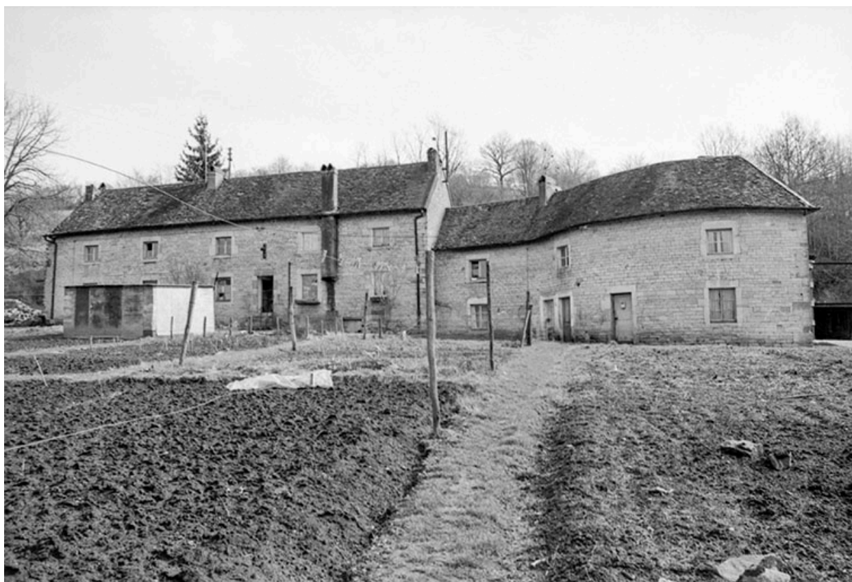
Logements ouvriers à l'entrée (aile nord) en 1979.
