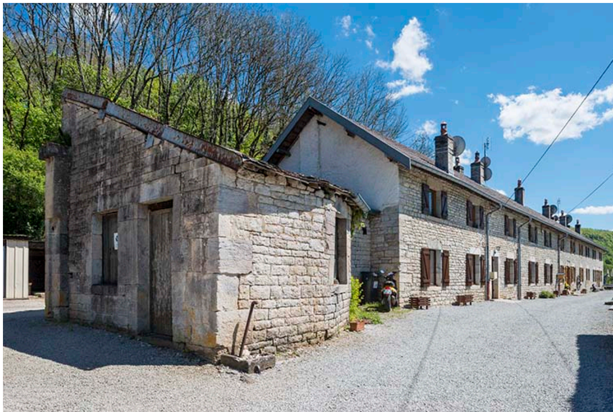
Logement ouvrier (aile sud).
