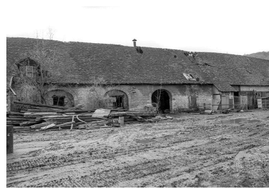
Bâtiments industriels sur l'île en 1979.
