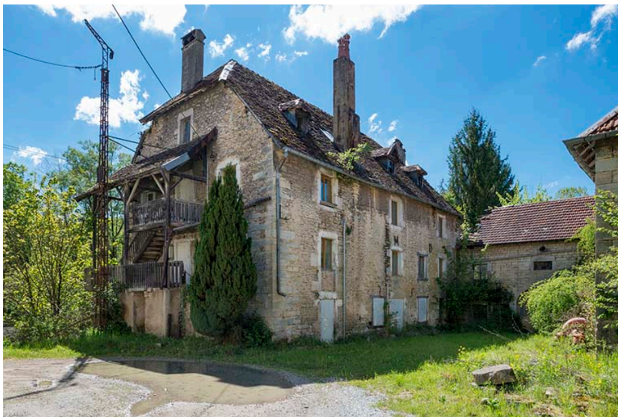
Bâtiment du moulin (puis logement ouvrier).
