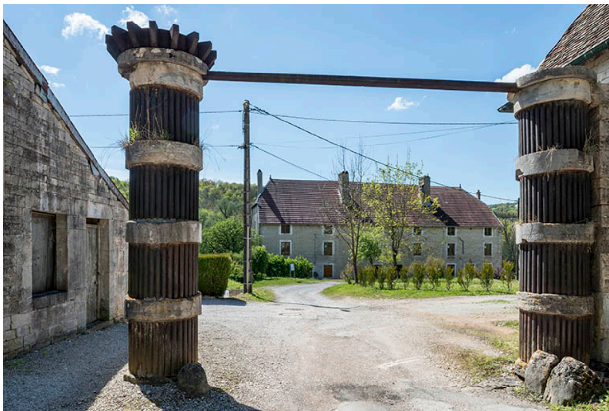
Portique d'entrée. Piliers fasciculés (pierre et fonte).
