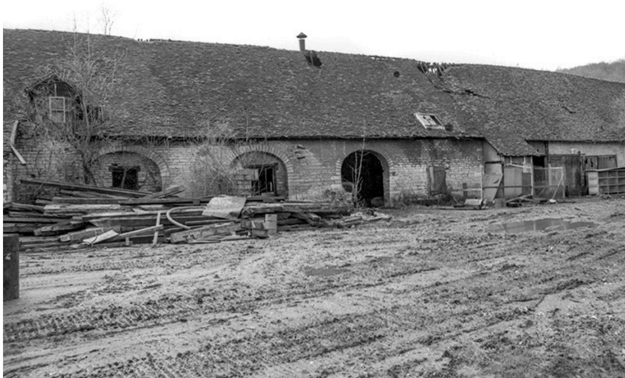
Bâtiments industriels sur l'île en 1979.
