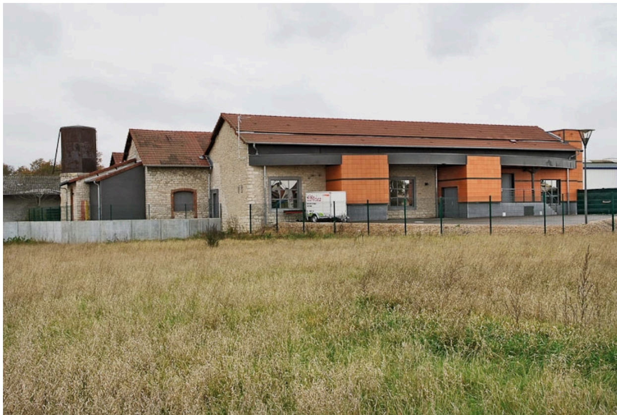
Vue d'ensemble du bâtiment.
