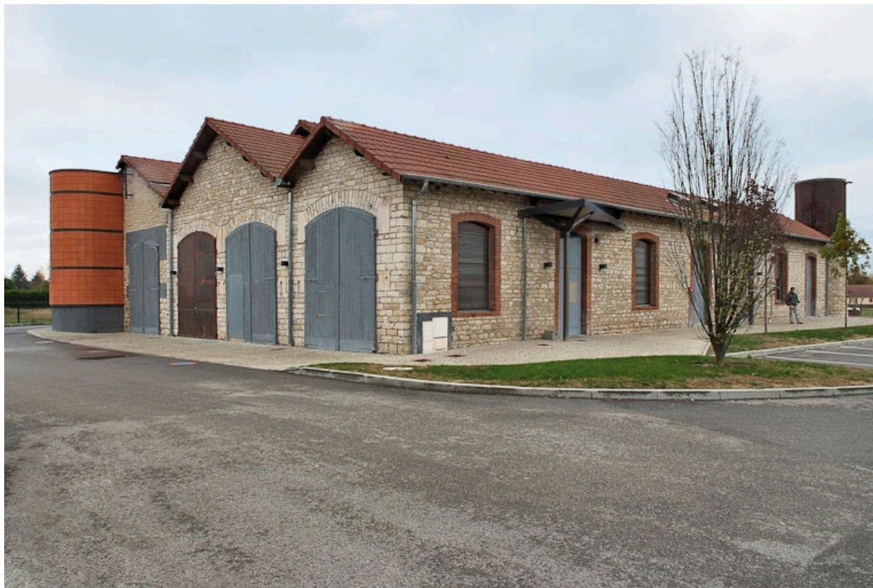
Vue d'ensemble du bâtiment.
