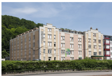
Hôtel n°1. Phot. Jérôme Mongreville IVR43_20122501805NUC4A
