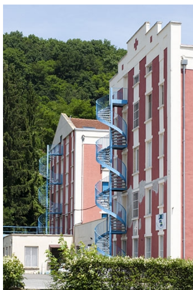
Immeubles de dortoirs. Pignons ouest.
