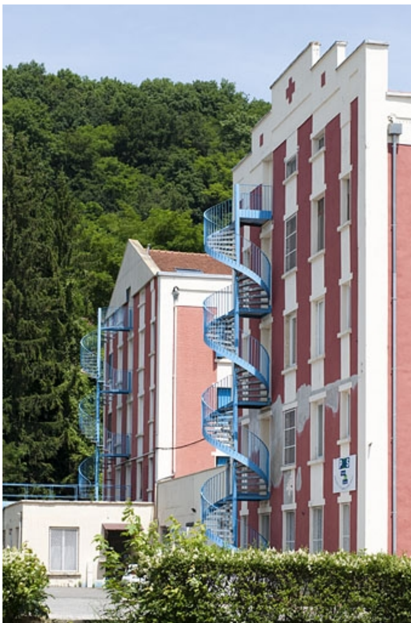
Immeubles de dortoirs. Pignons ouest.
