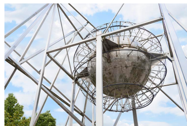
Détail de la sphère. Phot. Mary Ruffinoni IVR43_20147000004NUC4A
