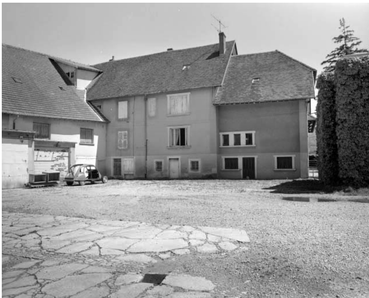
Façade postérieure du logement.
