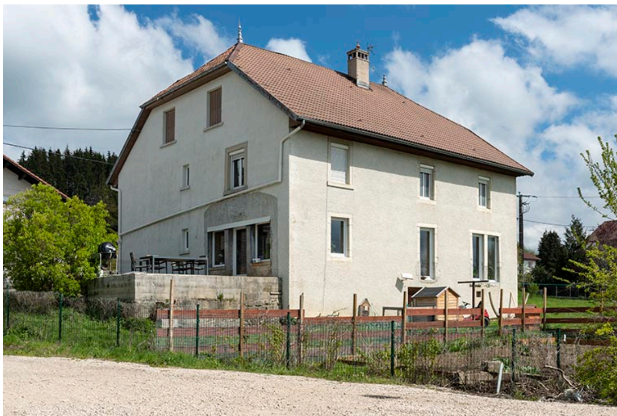
Façades postérieure et latérale droite.
