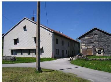
Pignon sud-ouest vu de trois quarts. Phot. Marie-Pierre Reynet IVR43_20083900297NUC1A
