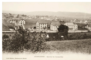
Audincourt. Quartier des automobiles : carte postale, Metthez Photogr., Hérimoncourt, s.d. [fin 19e ou début 20e siècle]. Phot. Jérôme Mongreville, Autr. Metthez IVR43_20112500258NUC4A
