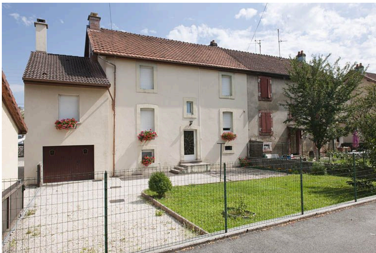
Rue de Verdun. Façade postérieure d'une habitation.
