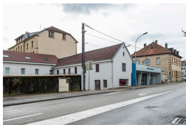
Vue d'ensemble depuis la rue du Mont.
