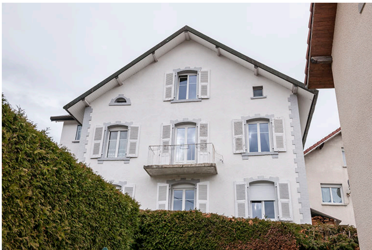
Façade latérale droite, vue en contre-plongée.
