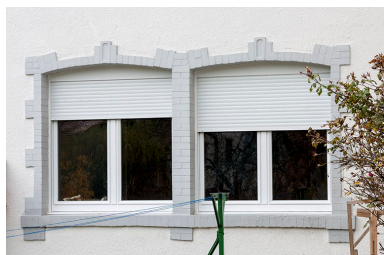
Façade postérieure : fenêtre horlogère. Phot. Jérôme Mongreville IVR43_20152502169NUC4A
