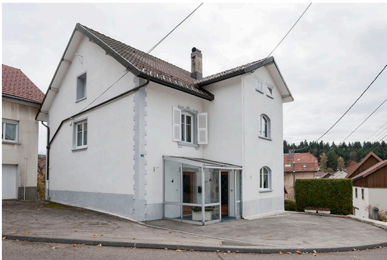
Façades antérieure et latérale gauche.
