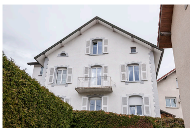
Façade latérale droite, vue en contre-plongée. Phot. Jérôme Mongreville IVR43_20152502172NUC4A
