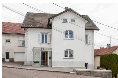
Façade antérieure. Phot. Jérôme Mongreville IVR43_20152502170NUC4A
